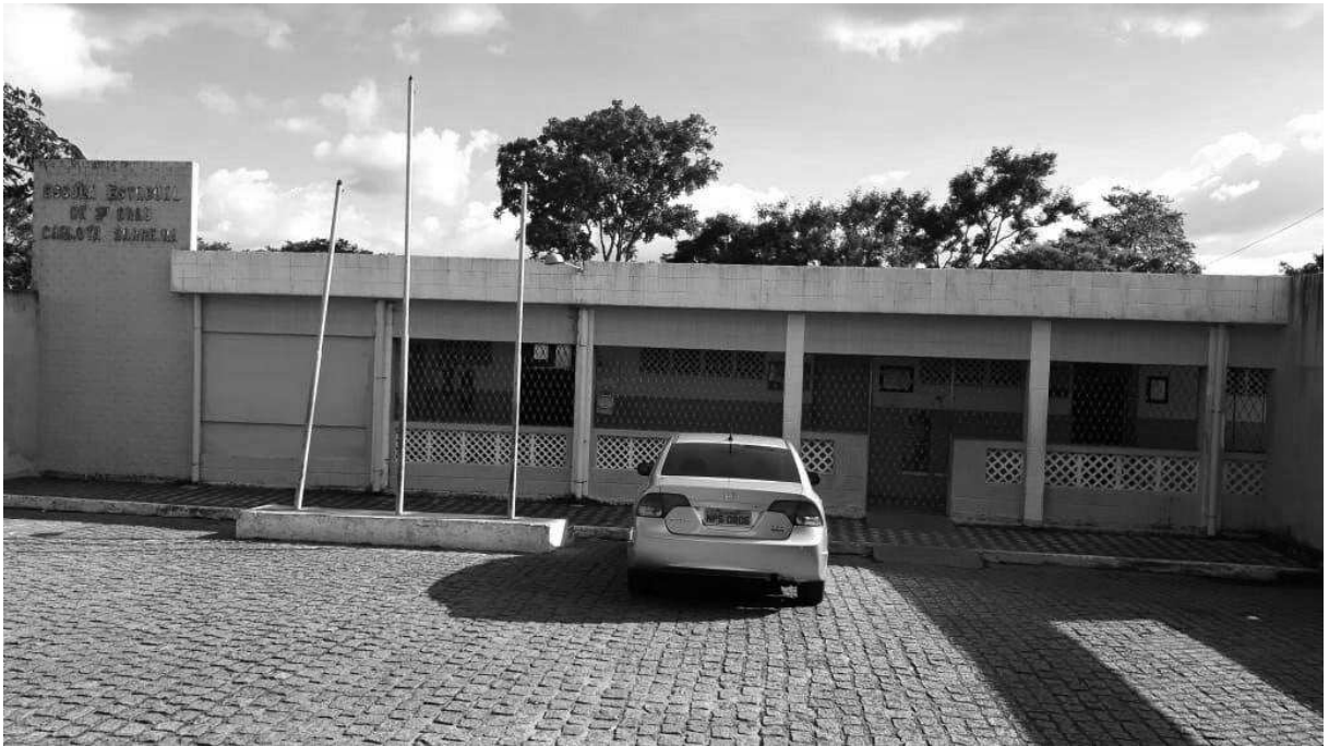
Figura 5: Visão da fachada da Escola Estadual de Ensino Fundamental e Médio ‘Carlota Barreira’.
