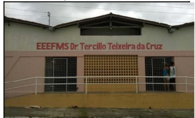
Figura 4: Aspectos da fachada da EEEFMDTTC, Tacima/PB
