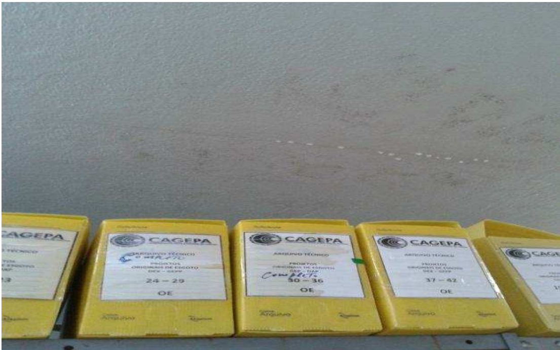
Figura 16: Goteiras consequência de infiltração
