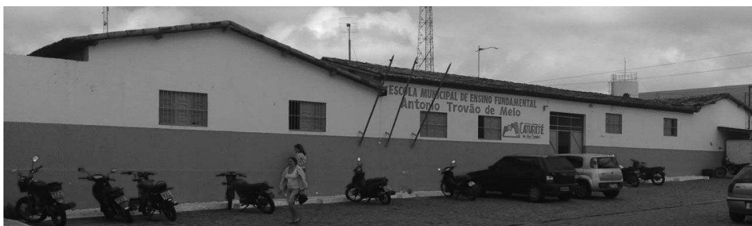
Figura 1- Fachada da Escola
