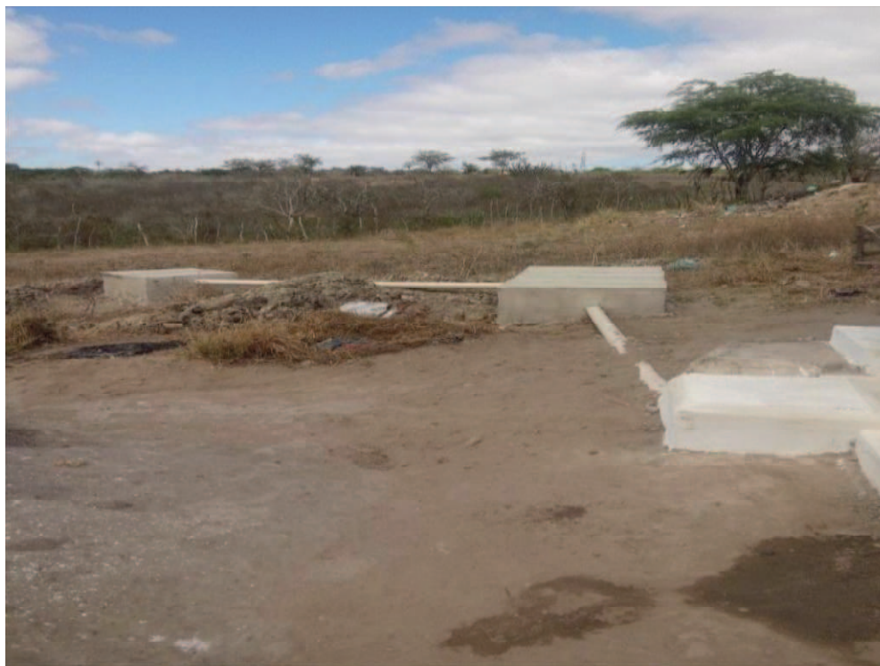
Figura 12: Tanque Séptico e Sumidouro.
