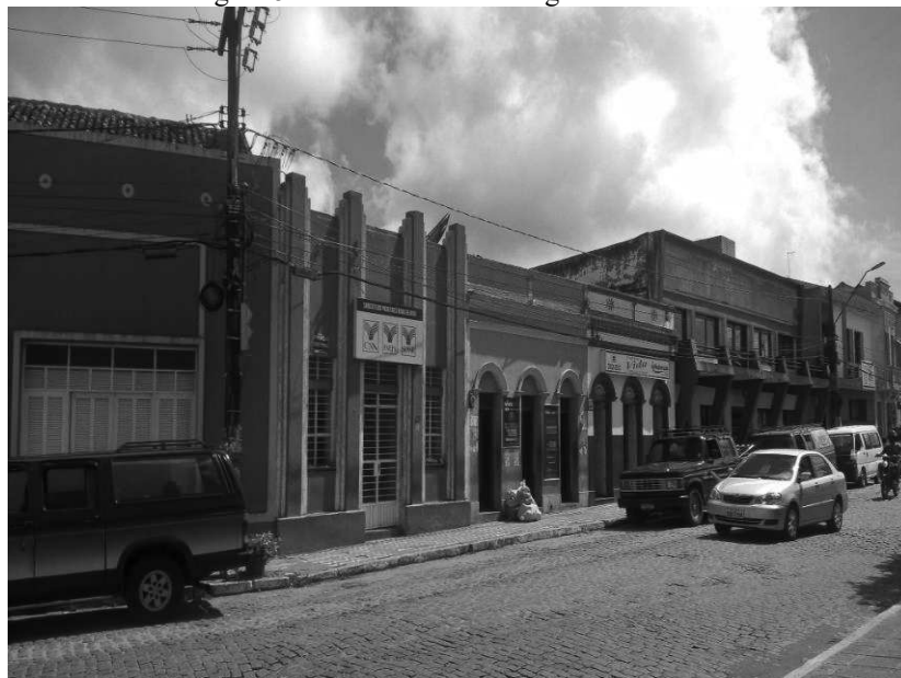
Figura 5: Fachadas Emater e agência São José
