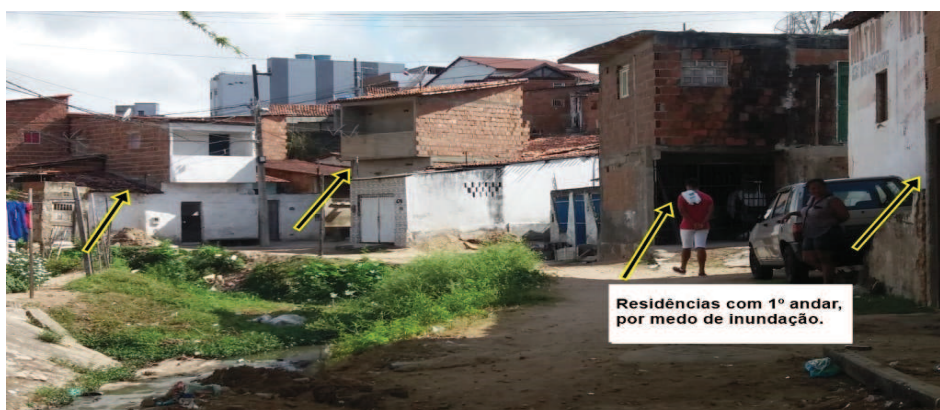
Figura 8– Estruras com elevação, para evitar inundação
