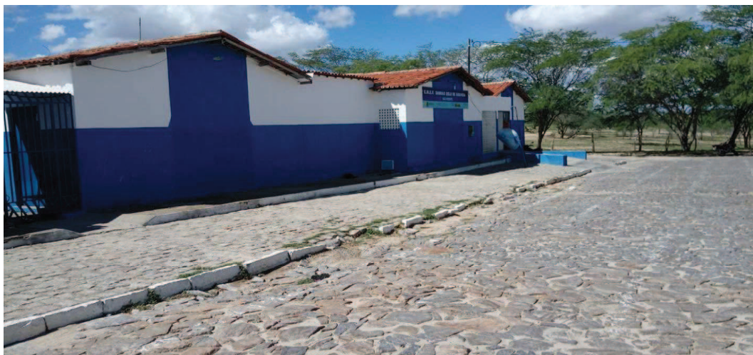
Figura 01: Fachada da E.M.E.F. Damião Zelo de Gouveia. Fonte: Arquivo pessoal de estágio, 2018.
