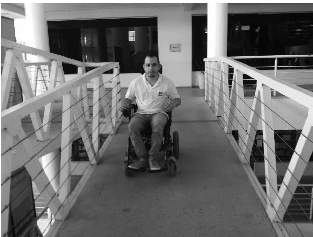
Figura 8: Estrutura das rampas da Central de Aulas.
