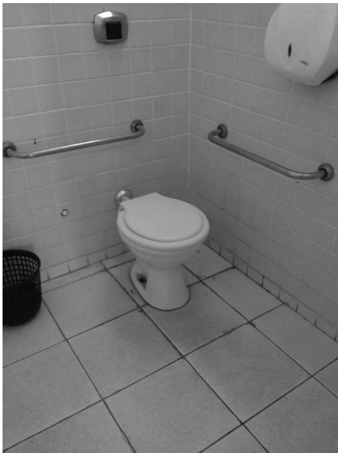
Figura 3: Estrutura dos banheiros do prédio da Central de Aulas.
