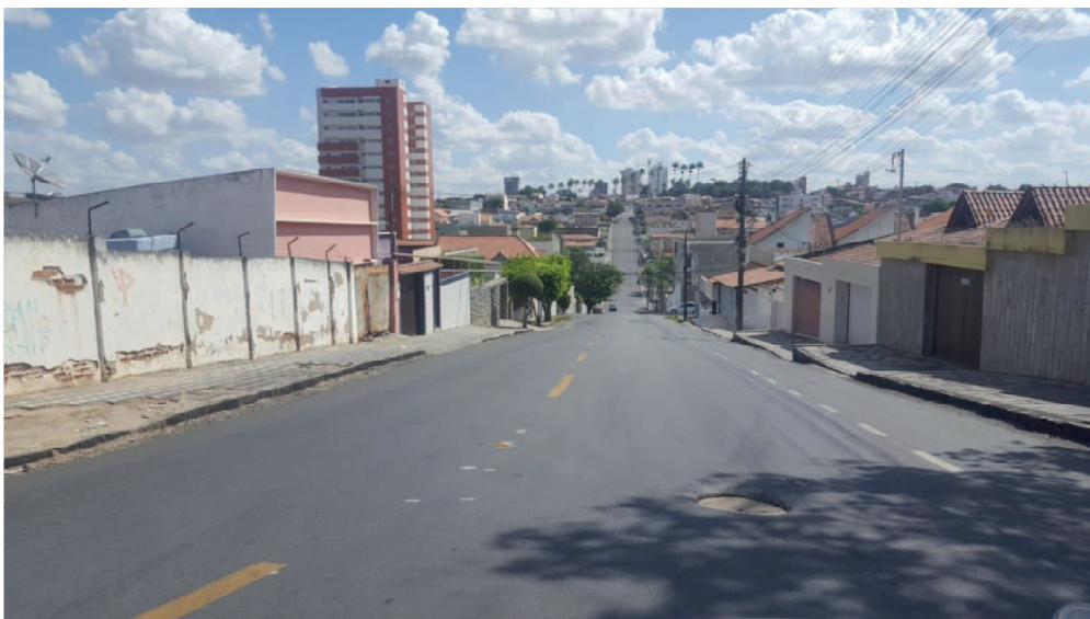
Figura 19: Rua Ver. Manoel Uchôa depois da pavimentação asfáltica
