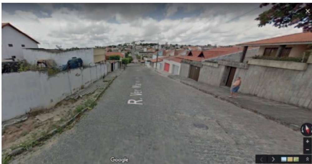
Figura 18: Rua Ver. Manoel Uchôa antes da pavimentação asfáltica
