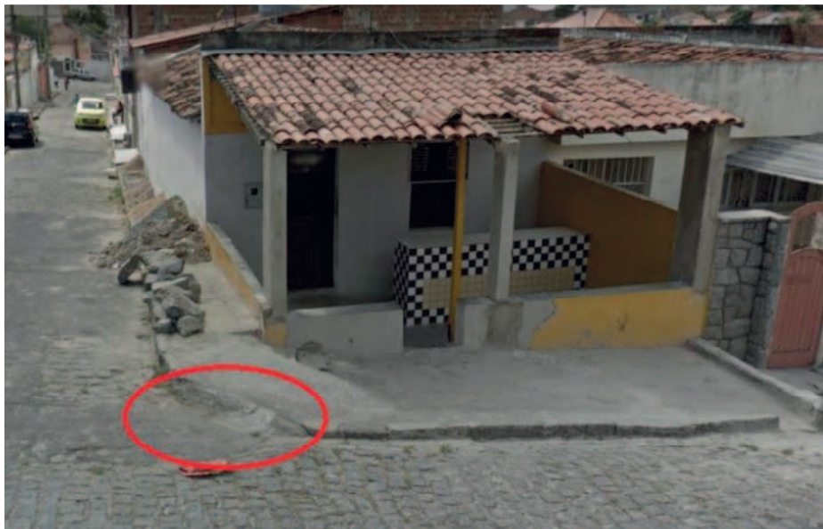
Figura 13: Tampa coletora fechada com cimento
