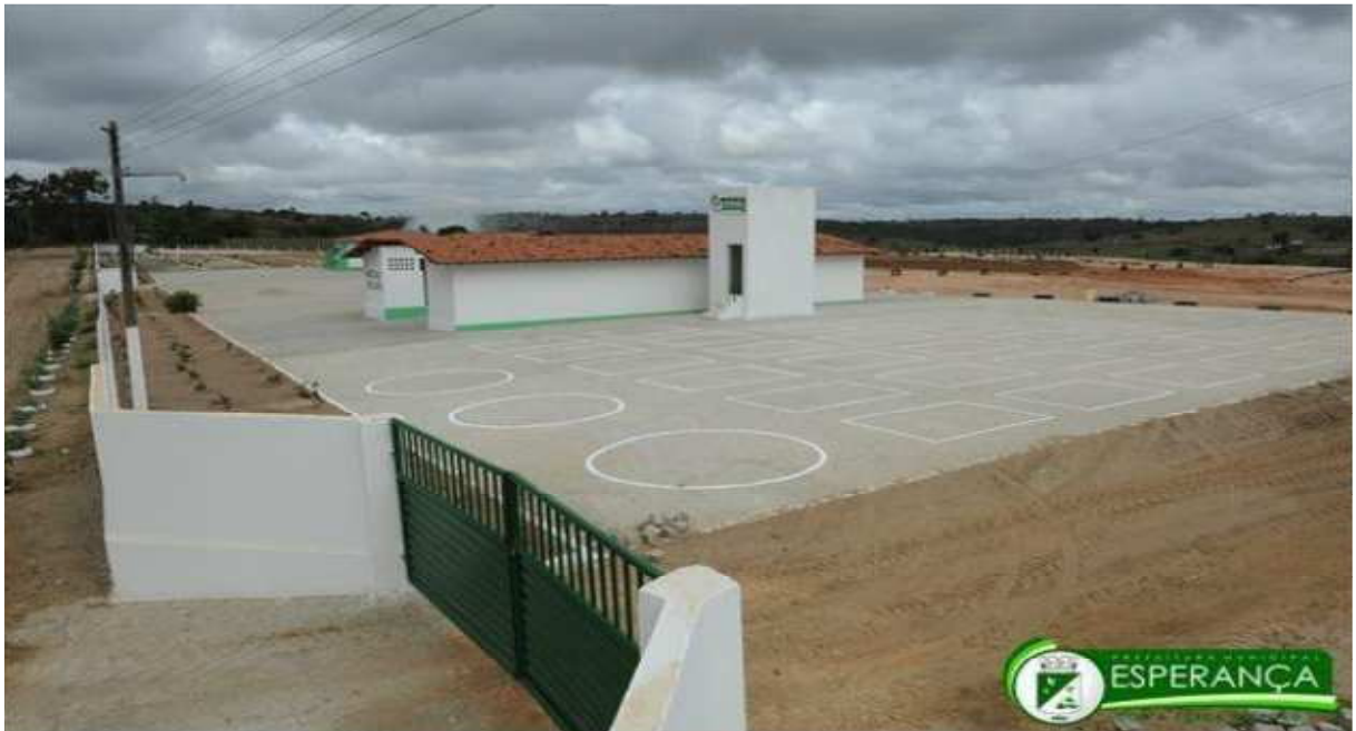
Figura 4. Unidade de Triagem e Compostagem de Resíduos Domiciliares de Esperança – PB (ENTRADA).
