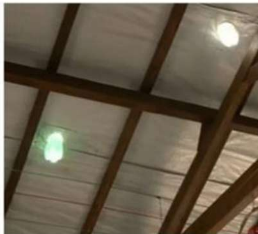
Figura 10: Captação de energia solar com garrafa pet e água, fixado no teto.
