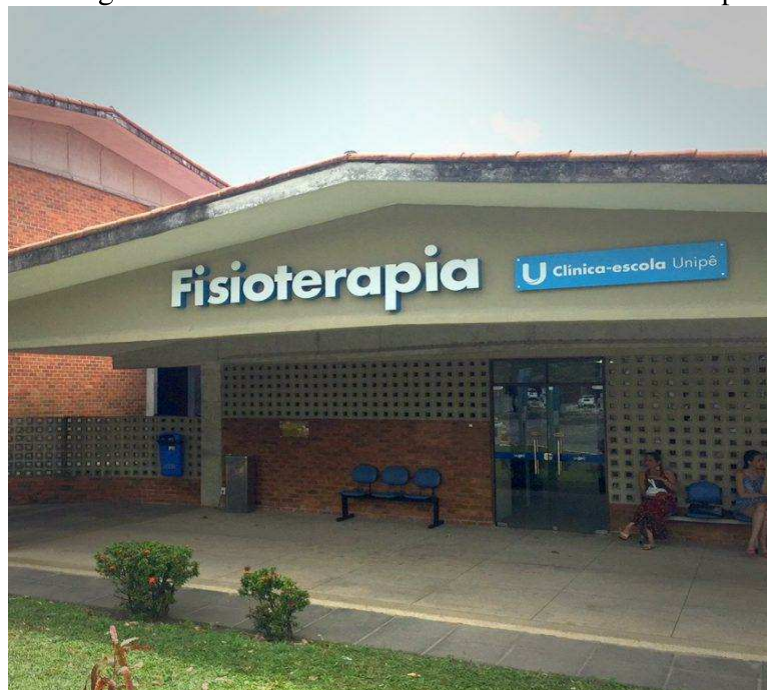
Figura 15 - Fachada da Clínica-Escola de Fisioterapia
