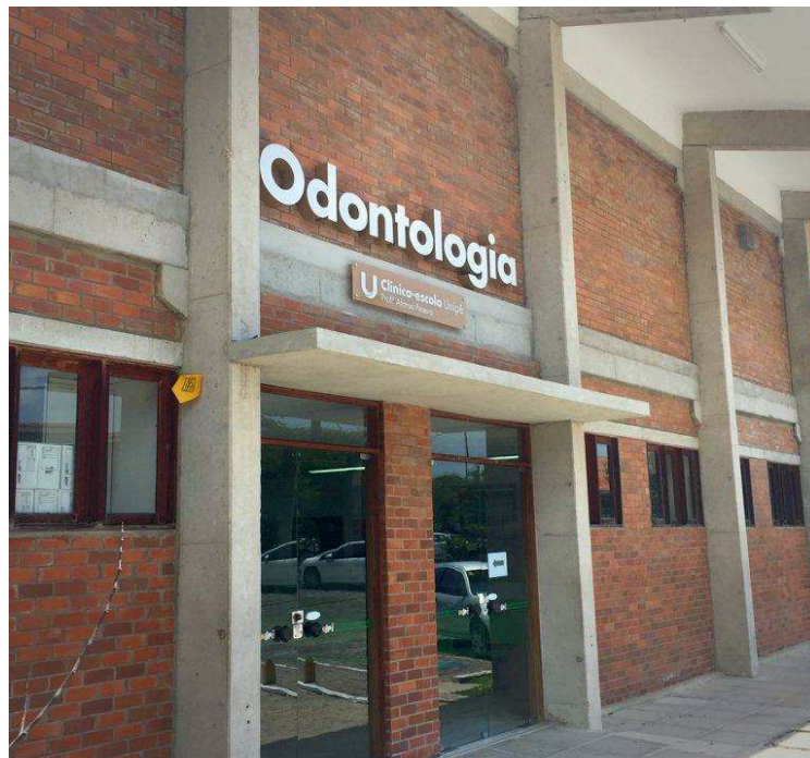
Figura 10 - Fachada da Clínica-Escola de Odontologia.
