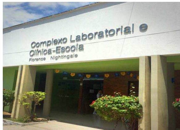
Figura 18 - Fachada da Clínica-Escola de Enfermagem.
