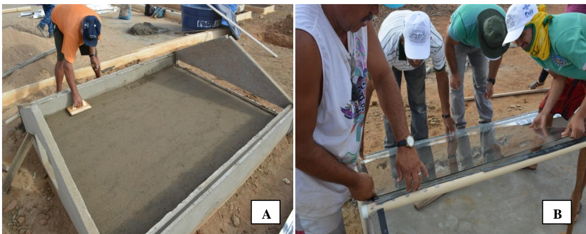
Figura 4: A) Piso cimentado; B) Fixação dos Vidros.
