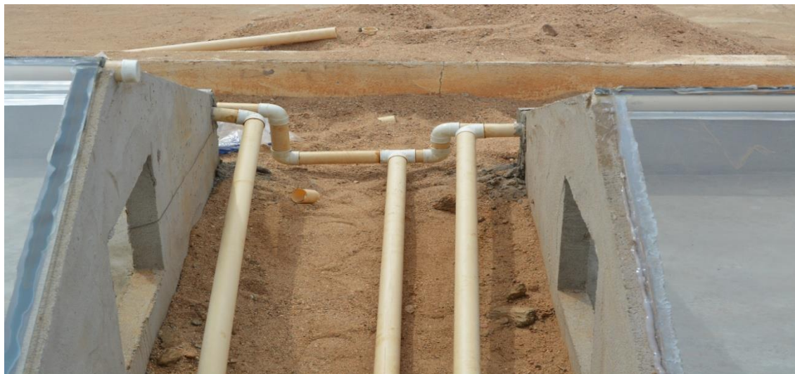
Figura 5: Saída da água doce do sistema de dessalinização solar
