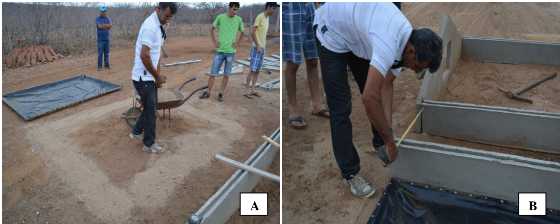
Figura 3: A) Nivelamento do piso; B) Esquadro das casinhas.
