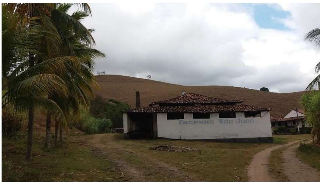
Foto 19: Engenho São João local onde um dos entrevistados trabalhou. Fonte: Acervo da autora.
