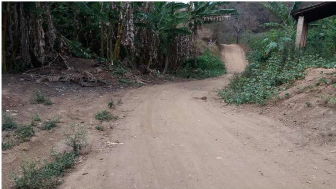
Foto 14: Estrada localizada na direção nordeste da comunidade a mesma é de grande importância pois é utilizada pelos trabalhadores para chegarem aos trabalhos e as pessoas para se locomover para a cidade de Alagoinha esta é a estrada que dá acesso ao engenho Ribeiro Novo. Fonte: Acervo da Autora.
