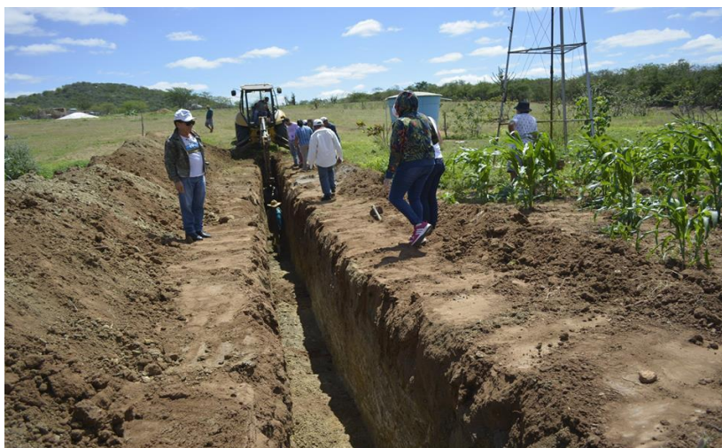
FIGURA 11: Escavação da vala
