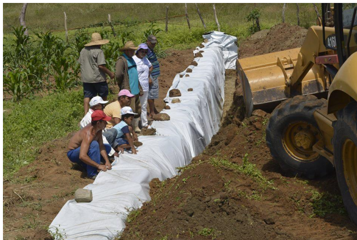
Figura 13: Enchimento da vala
