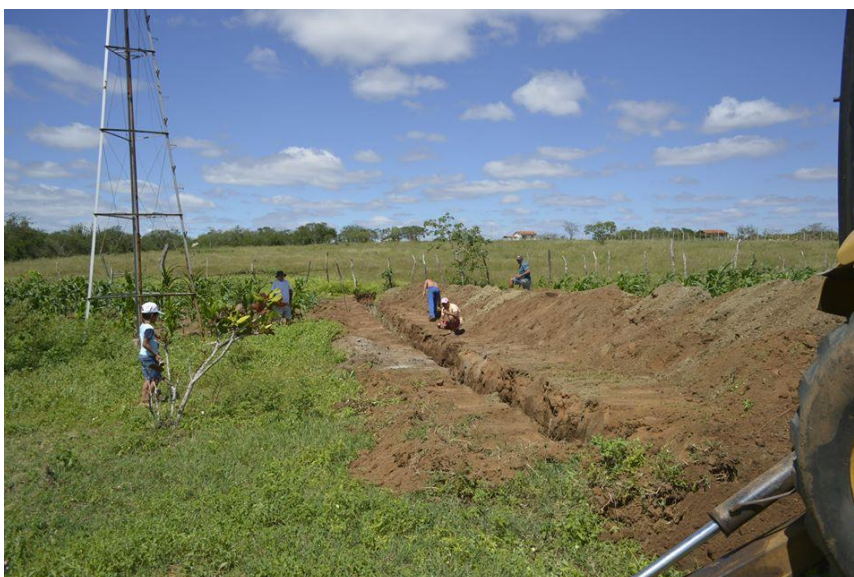
Figura 8: Construção da barragem
