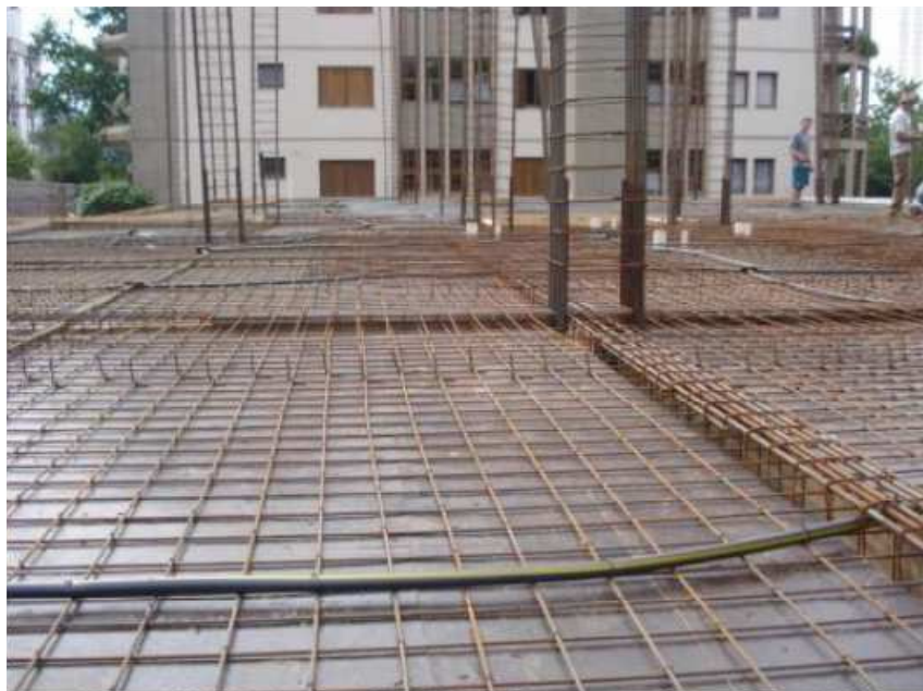
Figura 13 - Disposição de armaduras para lajes maciças.
