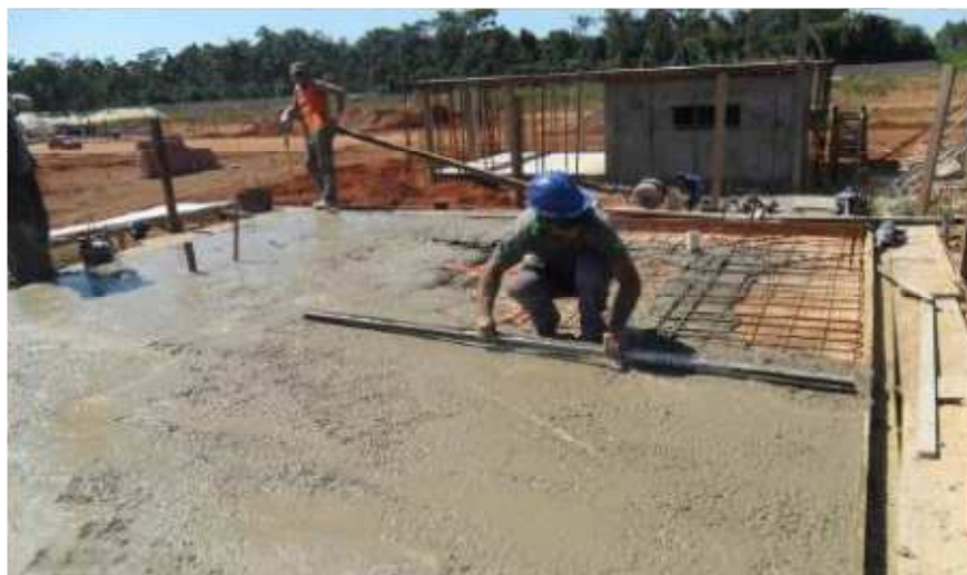
Figura 14 - Concretagem de lajes maciças.
