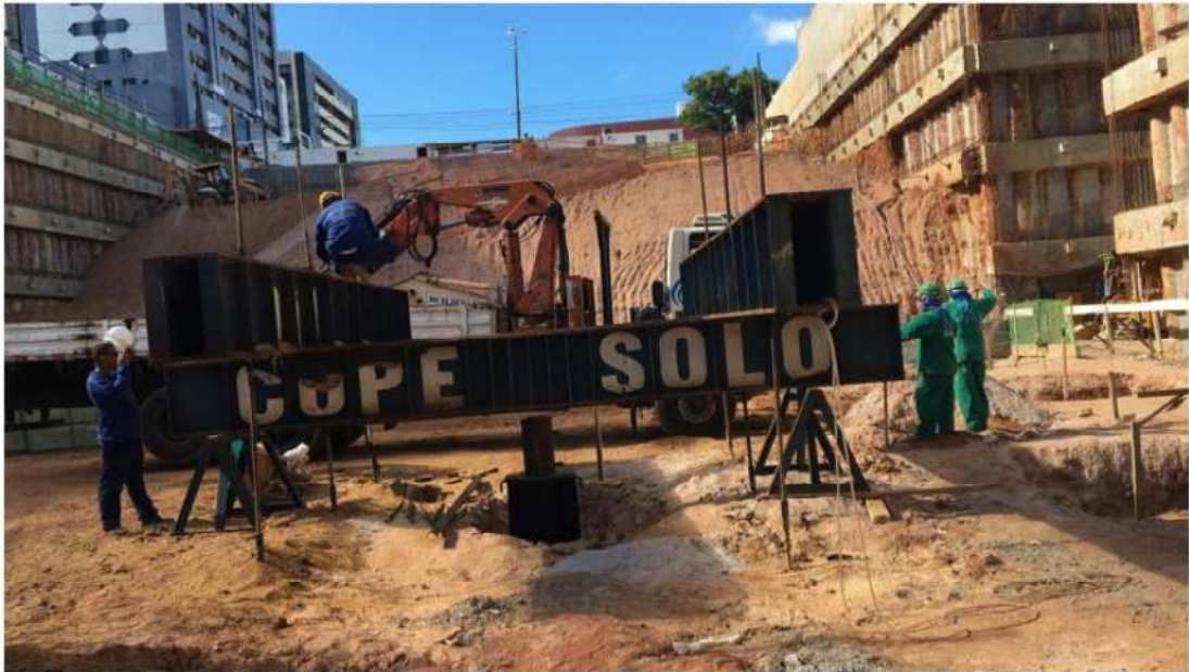
Figura 20 – Processo de montagem da prova de carga
