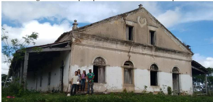
Figura 7 -Fachada principal do Casarão da Fazenda Maquiné.
