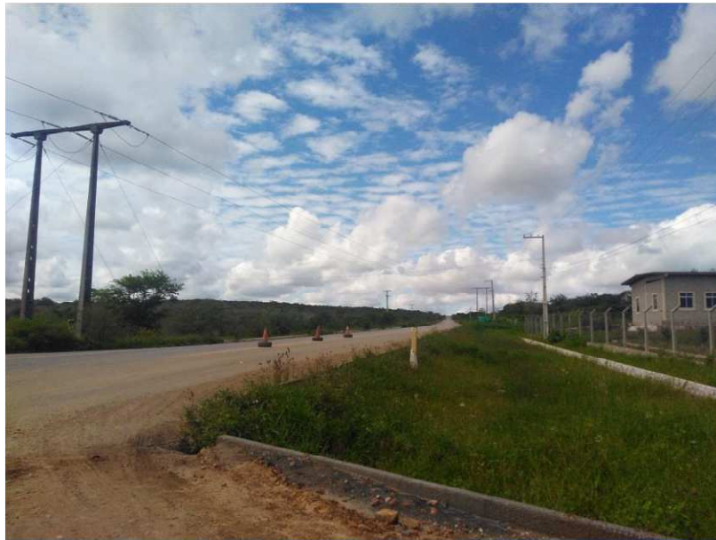
Figura 7 - Acesso asfaltado e área cercada com estacas de concreto
