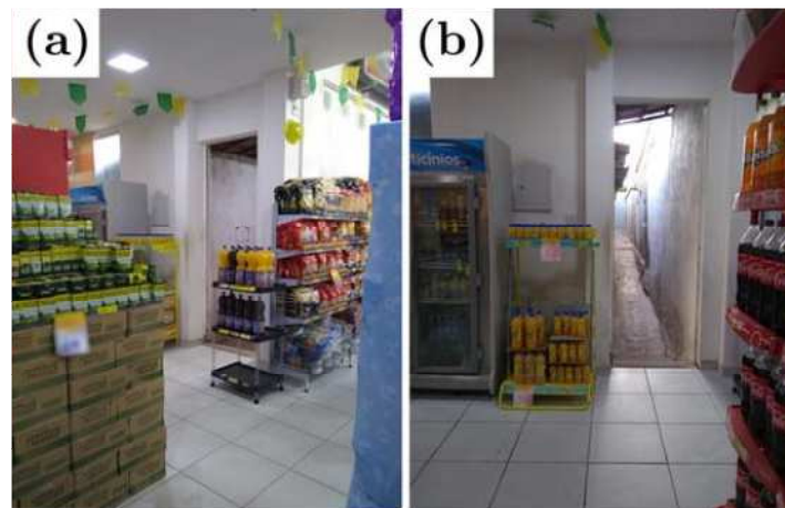
Figura 12 - Porta de saída de emergência, em que serve de acesso para a entrada de mercadorias.
