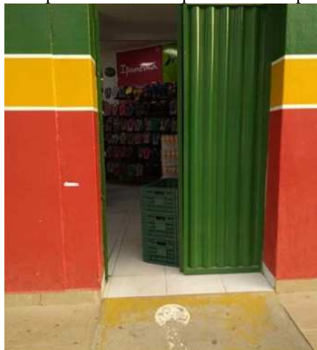
Figura 10 - Saída da parte frontal do hipermercado impedida por caixas.
