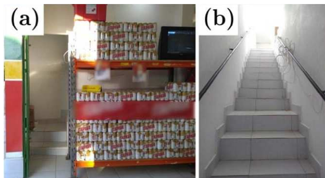
Figura 17 - Escada de acesso ao escritório, sala de reunião e depósito, próximo à entrada.
