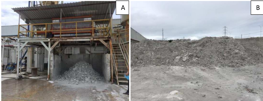
Figura 2- A) Reciclagem de água e obtenção do RPP B) Depósito de RPP Cerâmica Elizabeth
