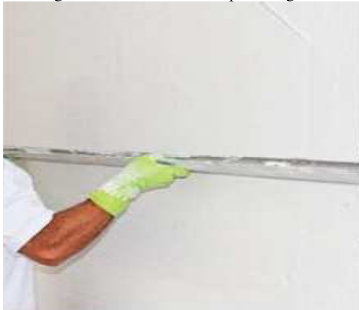
Figura 9 – Sarrafeamento da pasta de gesso.
