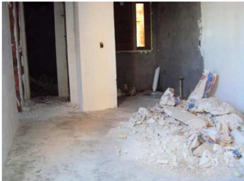
Figura 10 - Desperdício de material e formação de entulho.
