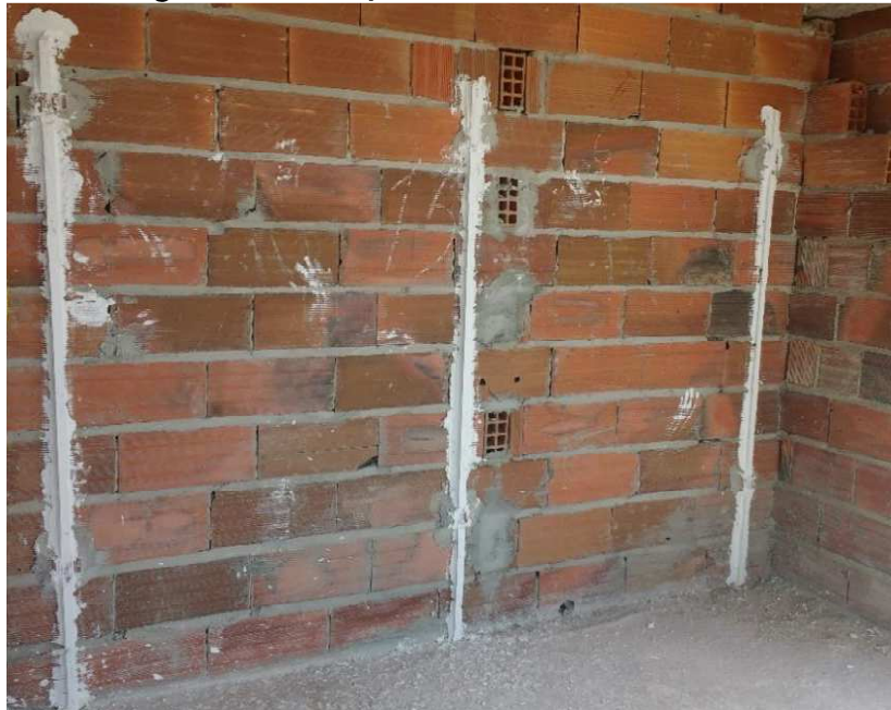
Figura 7 – Execução de mestras e taliscamento.
