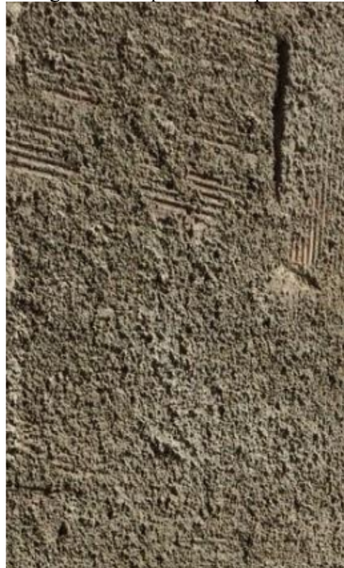
Figura 3 – Superfície chapiscada.
