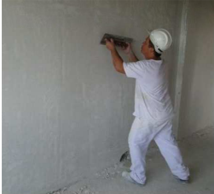
Figura 8 – Aplicação da argamassa de gesso com desempenadeira.
