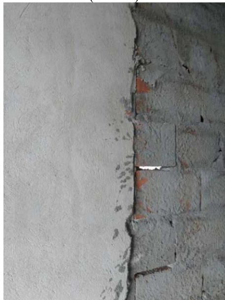
Figura 5 – Comparação de parede parte com emboço (esquerda) e parte com chapisco (direita).
