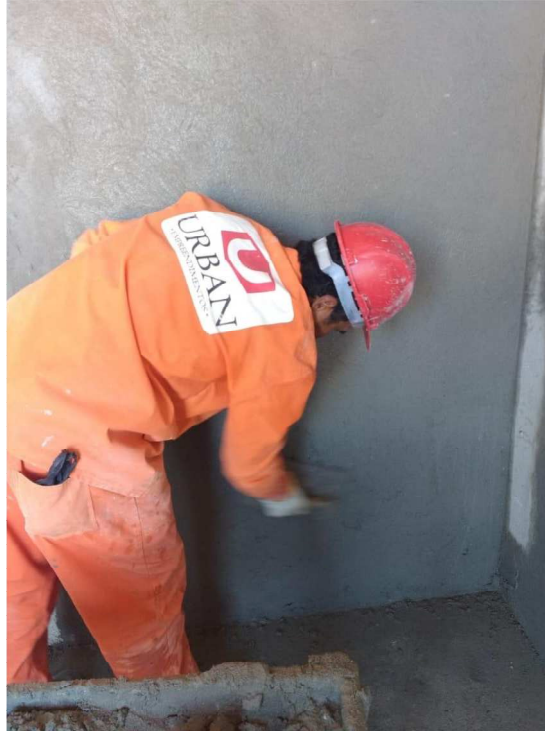
Figura 4 – Execução do emboço paulista.
