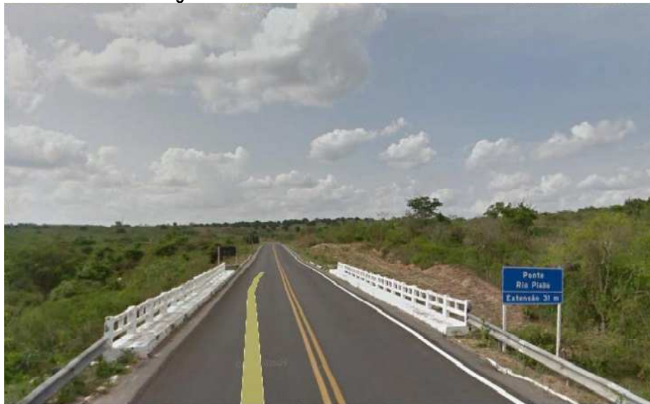
Figura 31- Ponte sobre o Rio Piaba.
