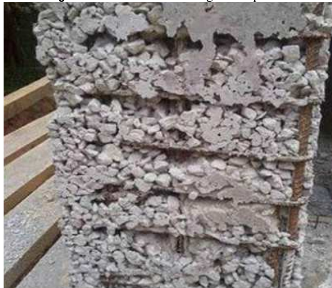
Figura 30- Nicho de concretagem em pilar.
