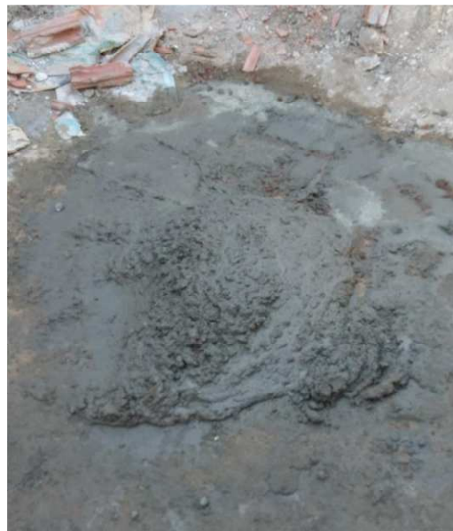
Figura 5 – Mistura dos componentes do concreto
