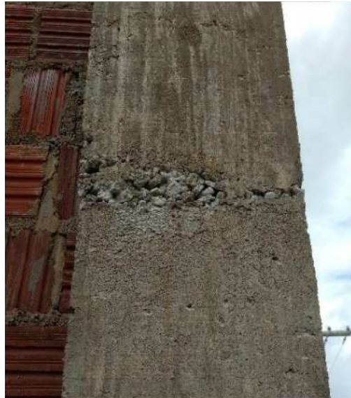
Figura 6 – Segregação dos componentes do concreto
