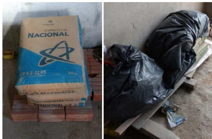
Figura 3 – Armazenamento do cimento nas obras estudadas
