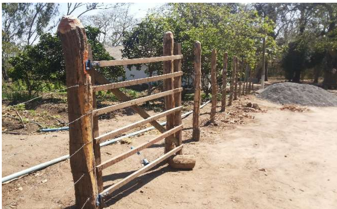
Figura 3. Cercamento da área destinada aos canteiros de plantas medicinais no Campus II da Universidade Estadual da Paraíba, Lagoa Seca/PB.
