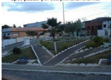
Figura 16 – Foto da Praça Miguel Fernandes após passar por sua primeira reforma.
