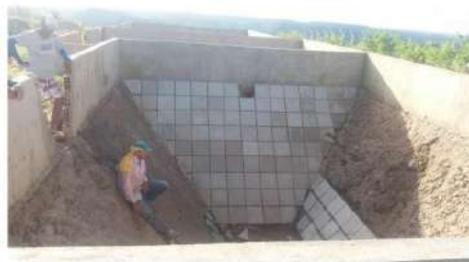
Figura 8. Tanque para chorume do aterro sanitário Dona Inês/PB
