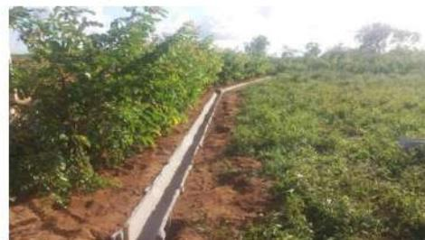
Figura 10. Vala para escoamento de água da chuva do aterro sanitário/Dona Inês-PB
