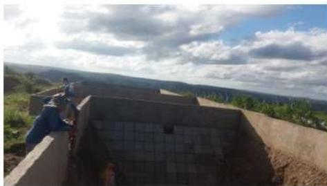
Figura 7. Tanque para chorume do aterro sanitário Dona Inês/PB
