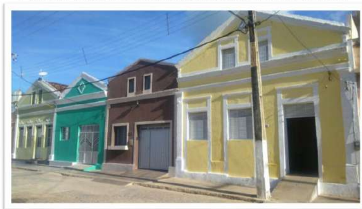
Figura 08– Casas construídas nas proximidades do Velho Mercado.
