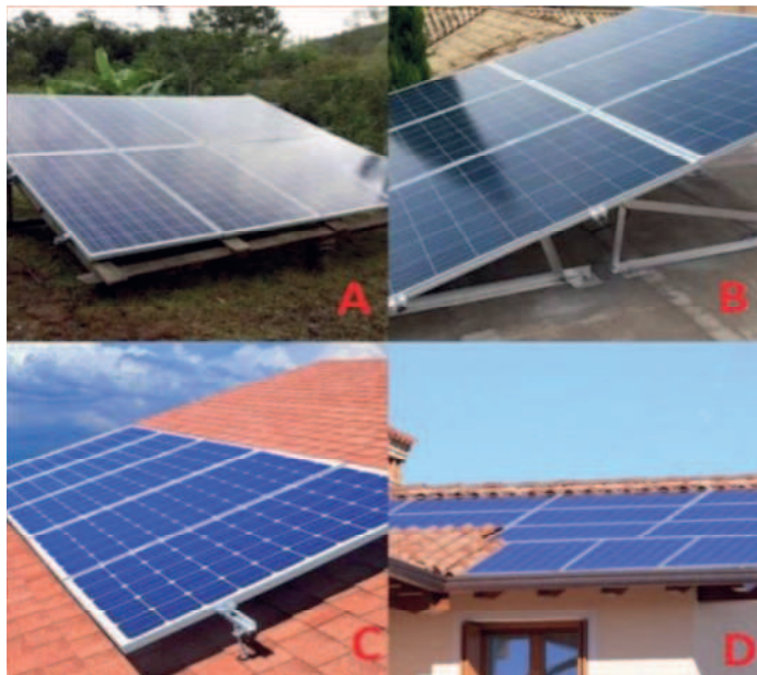
Figura 30: Tipos de estrutura fixação para painéis solares
