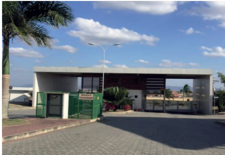
Figura 25 - Telhado da portaria
