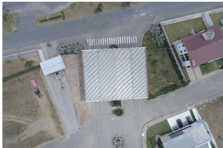
Figura 26 - Vista de cima do telhado da portaria
