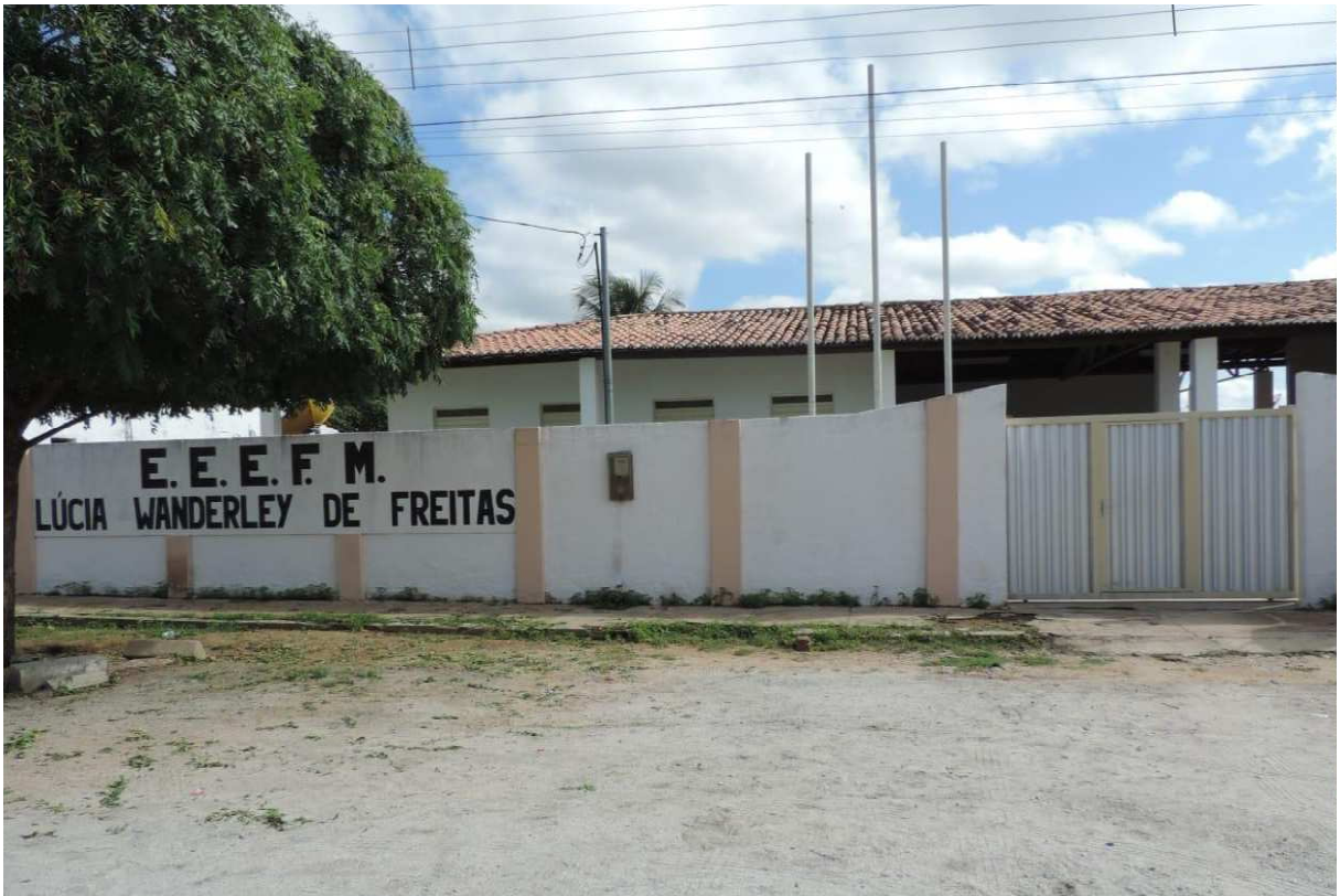
Foto 1 – Fachada da Escola
