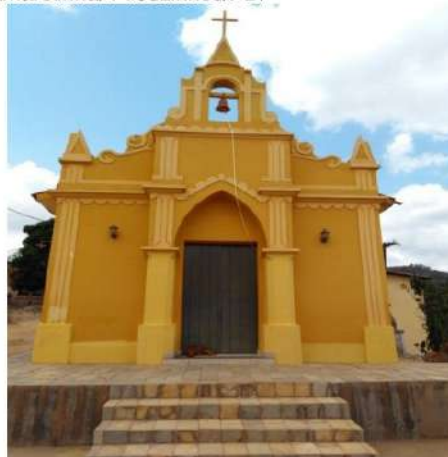
Figura 09: Capela de São Sebastião – Sítio Amarelinha/ Pilõesinhos/PB.
