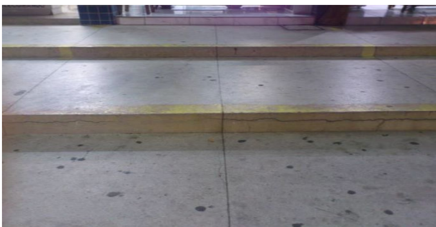
Figura 3: Degráus da calçada
