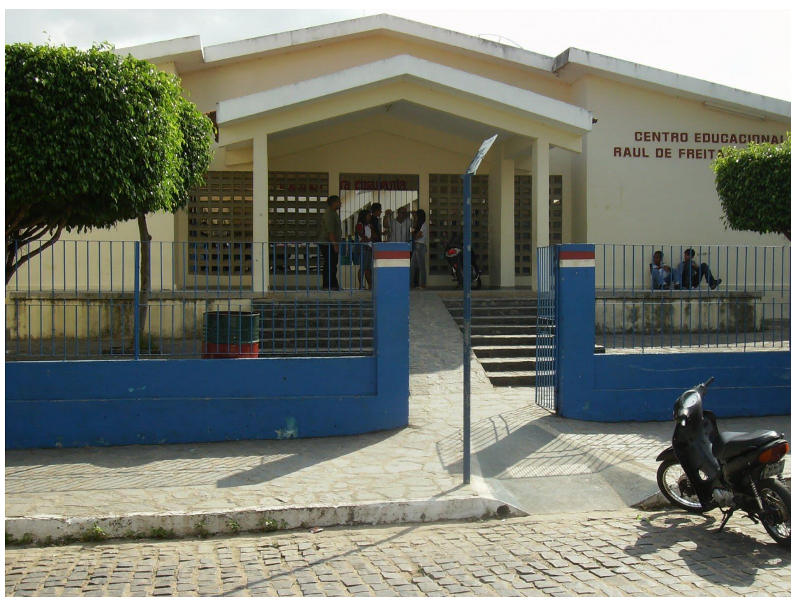
Figura 02 - Vista da parte da frente do CERFM
