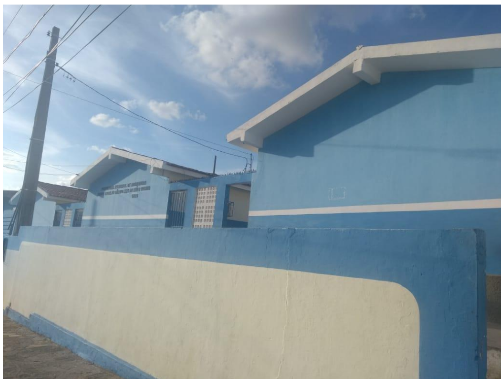
Figura 01 - Vista da parte da frente da Escola
