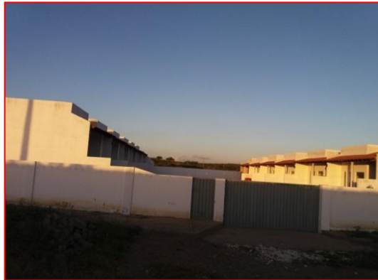
Figura 14: Residências localizada nas proximidades do Cemitério Público
