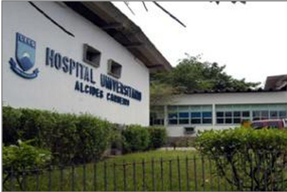
Figura 02: Hospital Universitário Alcides Carneiro, Campina Grande/PB. FONTE: www.alcidescarneiro.com
