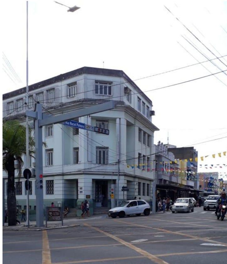
Figura 18 - Biblioteca Municipal de Campina Grande.
