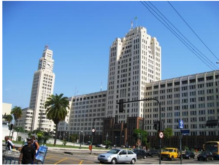
Figura 13 - Estação Central do Brasil no Rio de Janeiro.
