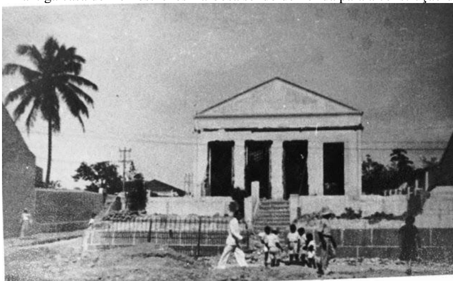
Figura 25 - A antiga casa de Demosthenes Barbosa sendo demolida para a construção dos Correios.
