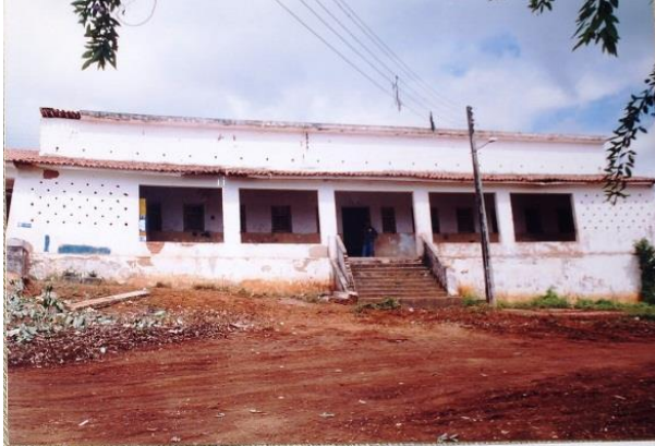
Figura 10: Antigo prédio abandonado do PSF II.
