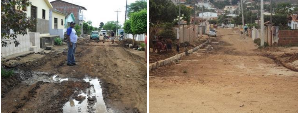
Figura 6a e 6b: Falta de pavimentação e saneamento básico em ruas das periferias.
