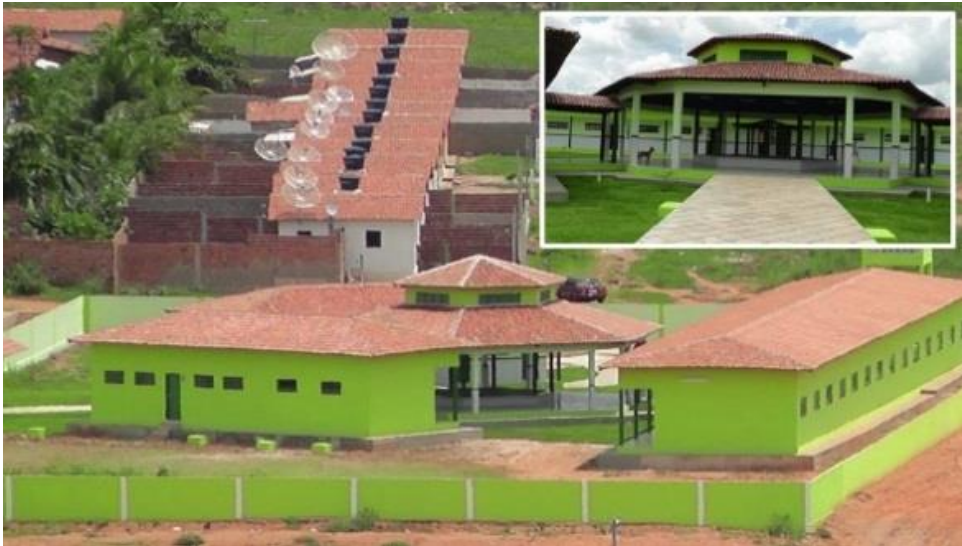
Figura 26: Novo prédio da Escola Municipal Carlos Martins Beltrão.
