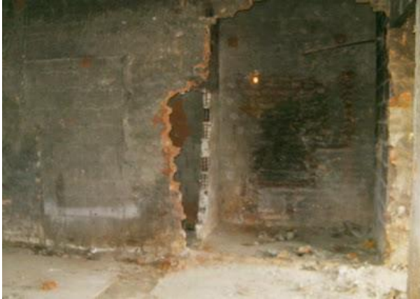
Figura 9: Interior do prédio do antigo PSF II.
