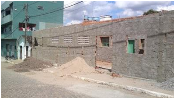
Figura 19: Reforma do PSF I
