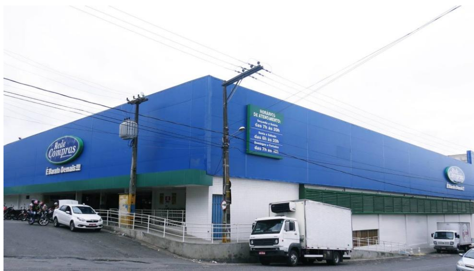
Figura 3: Visão parcial da fachada da loja III
