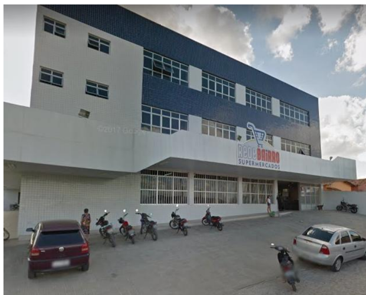
Figura 4: Visão parcial da fachada do RedeBairro
