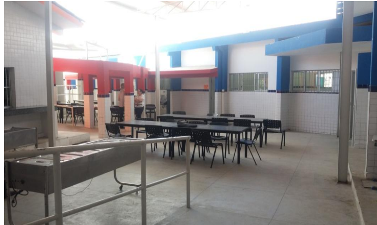
Figura 3 – Imagem parcial do refeitório da escola
