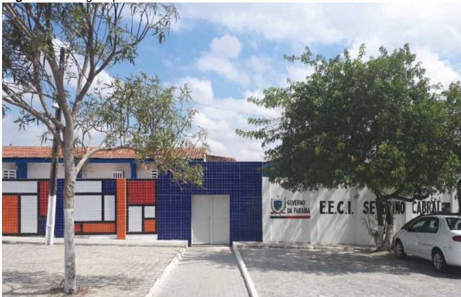
Figura 2 – Imagem parcial da fachada da escola
