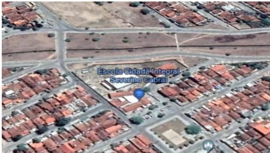
Figura 1 – Imagem panorâmica da E.E.C.I.R.C. captada por satélite
