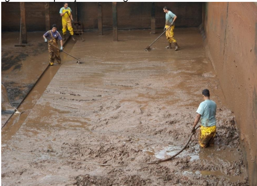
Figura: 9 – Operação de lavagem dos decantadores
