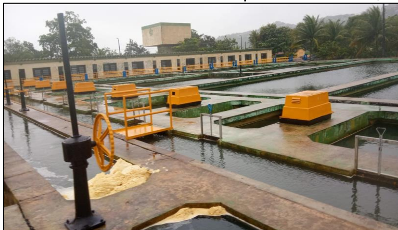
Figura 7 – Estação de tratamento de água (ETA) de Gravatá localizada no município de Queimadas, Paraíba.
