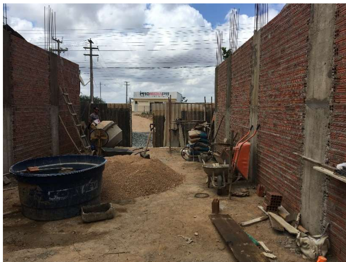
Figura 4 – Readequação do canteiro de obra
