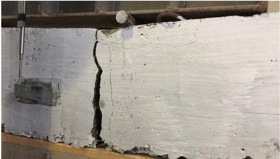
Figura 29 - Colapso da viga de concreto simples.
