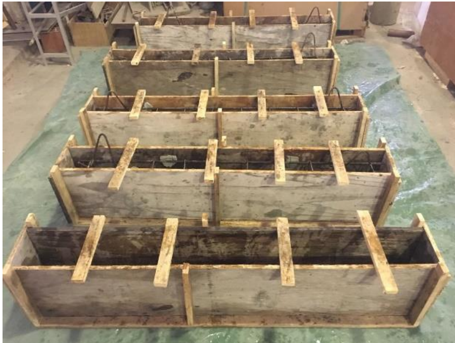
Figura 20 - Fôrmas de madeiras para moldagem de vigas.
