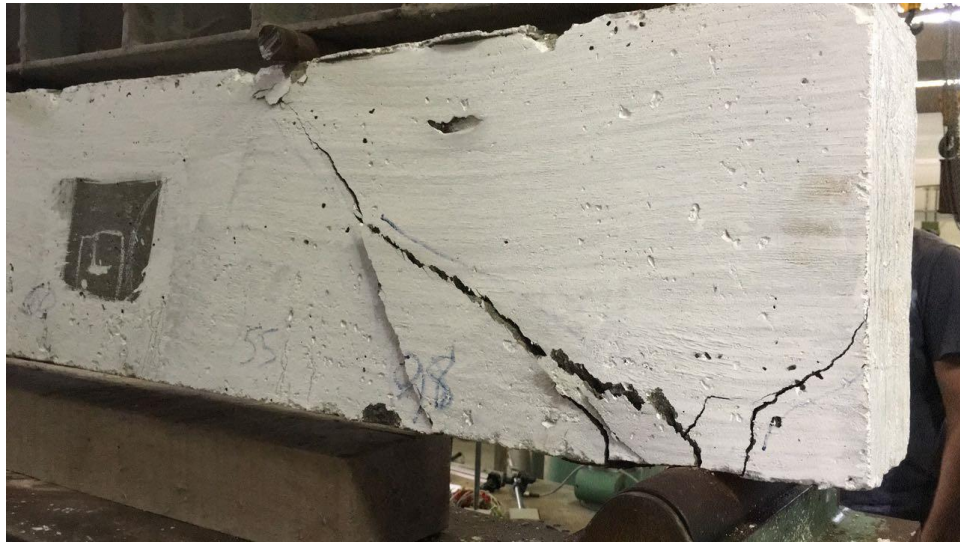
Figura 36 - Fissura inclinada na viga de seção grande.
