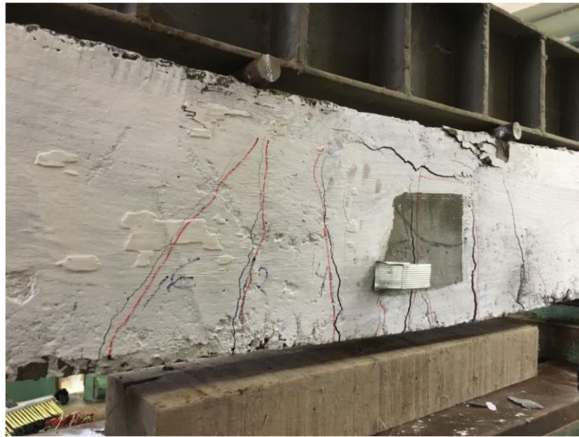
Figura 30 - Fissuração na região de flexão pura.
