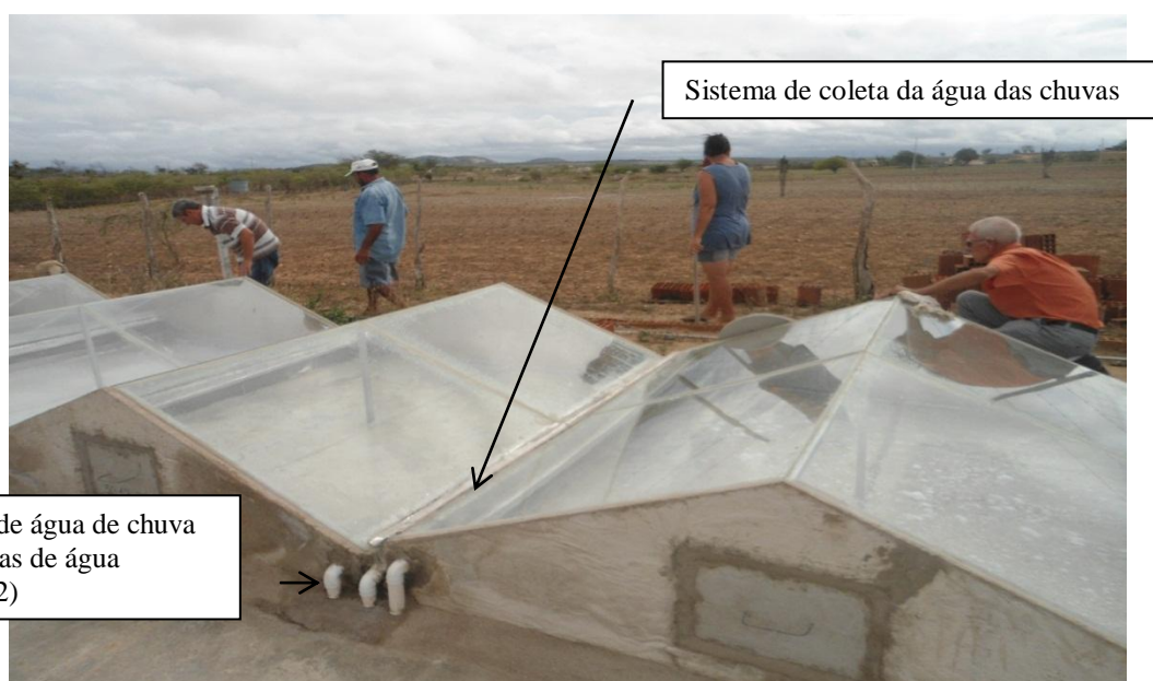
Figura 7: Dessalinizadores construídos sobre a cisterna calçadão.
