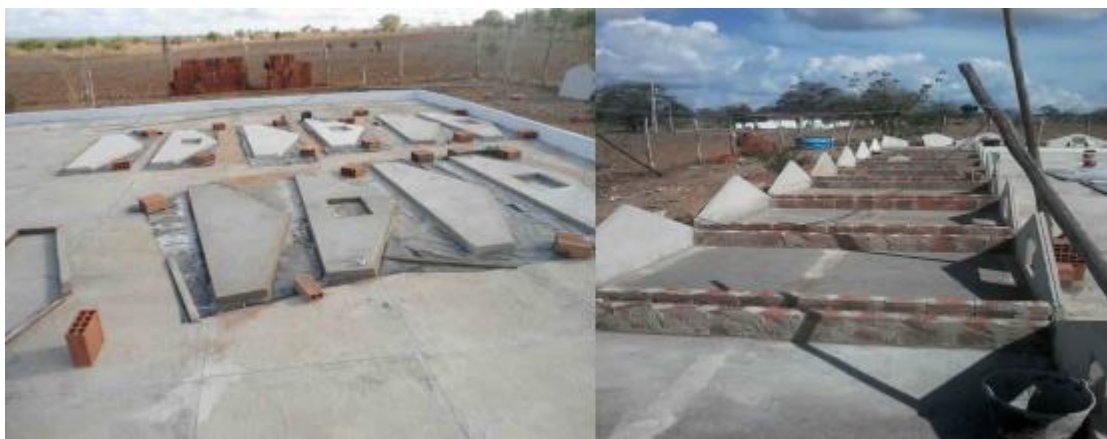
Figura 6: Dessalinizadores em construção sobre o calçadão utilizando-se blocos pré-moldados.
