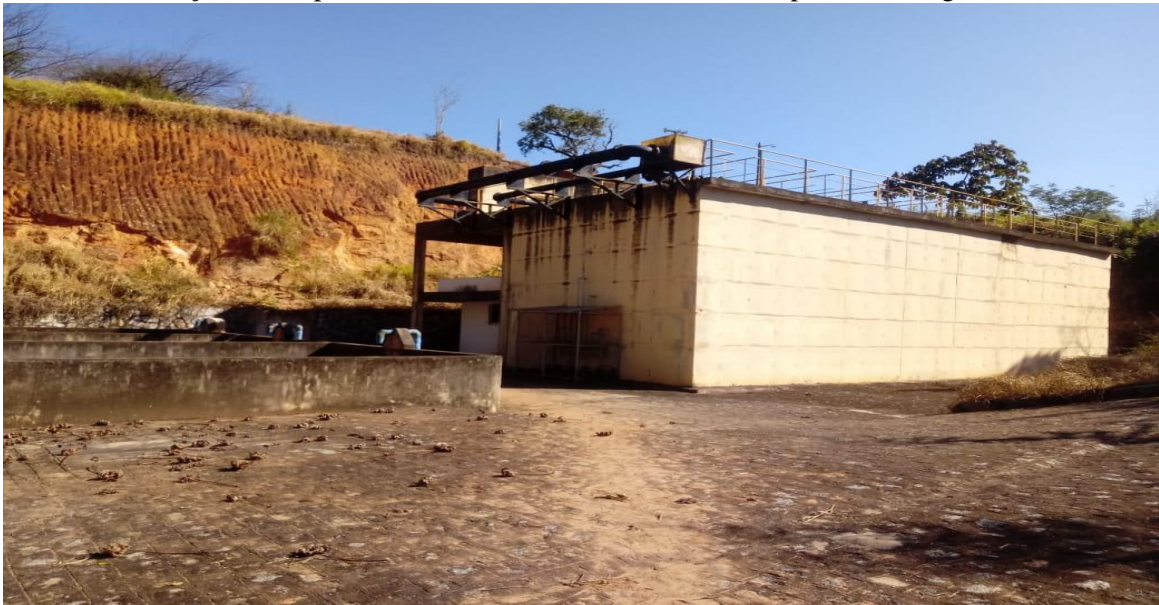
Foto 4: Estação Compactada de Tratamento do Município de Lagoa Seca-PB, 2019.
