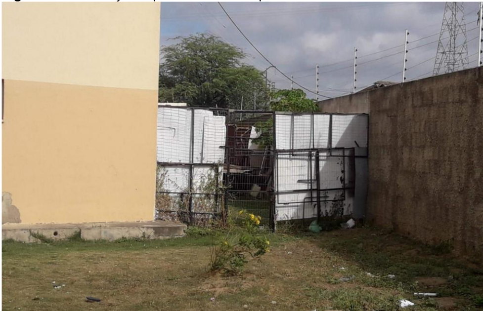
Figura 4 - Construção improvisada de um quintal.
