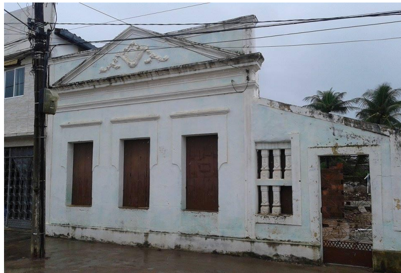
Figura 1- Fachada do prédio onde funcionou o Instituto Nossa Senhora do Carmo 42
