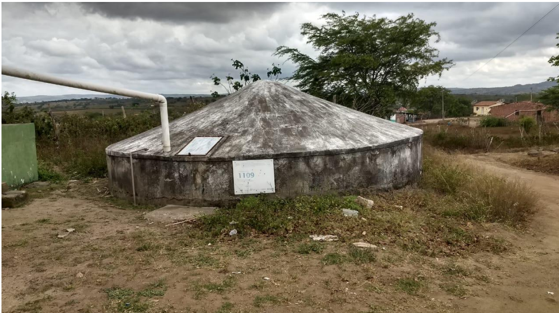
Fotografia 16 – Cisterna da Escola do Assentamento Gangungo
