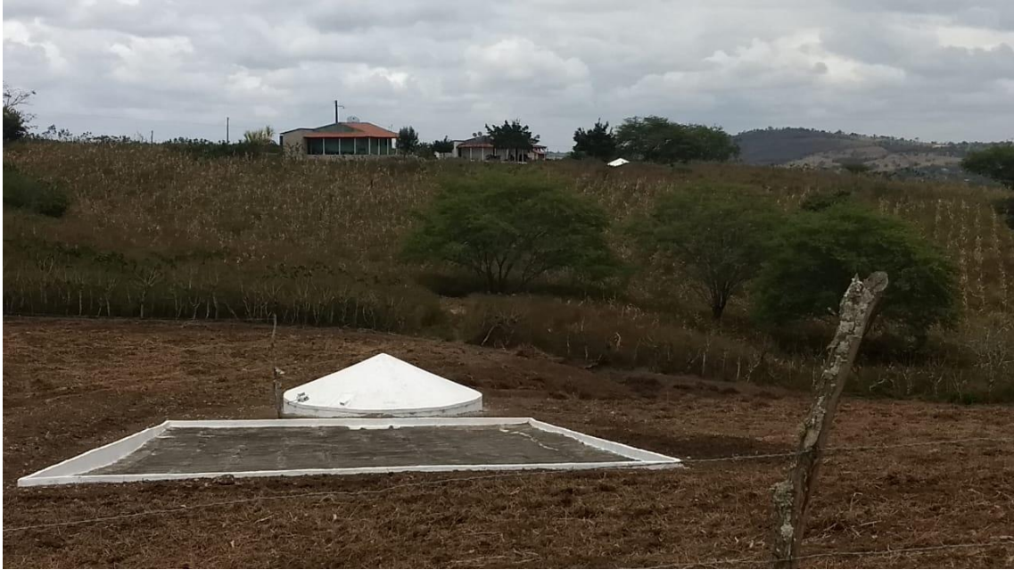
Fotografia 15 – Cisterna Calçadão do Programa Uma Terra e Duas Águas(P1+2)
