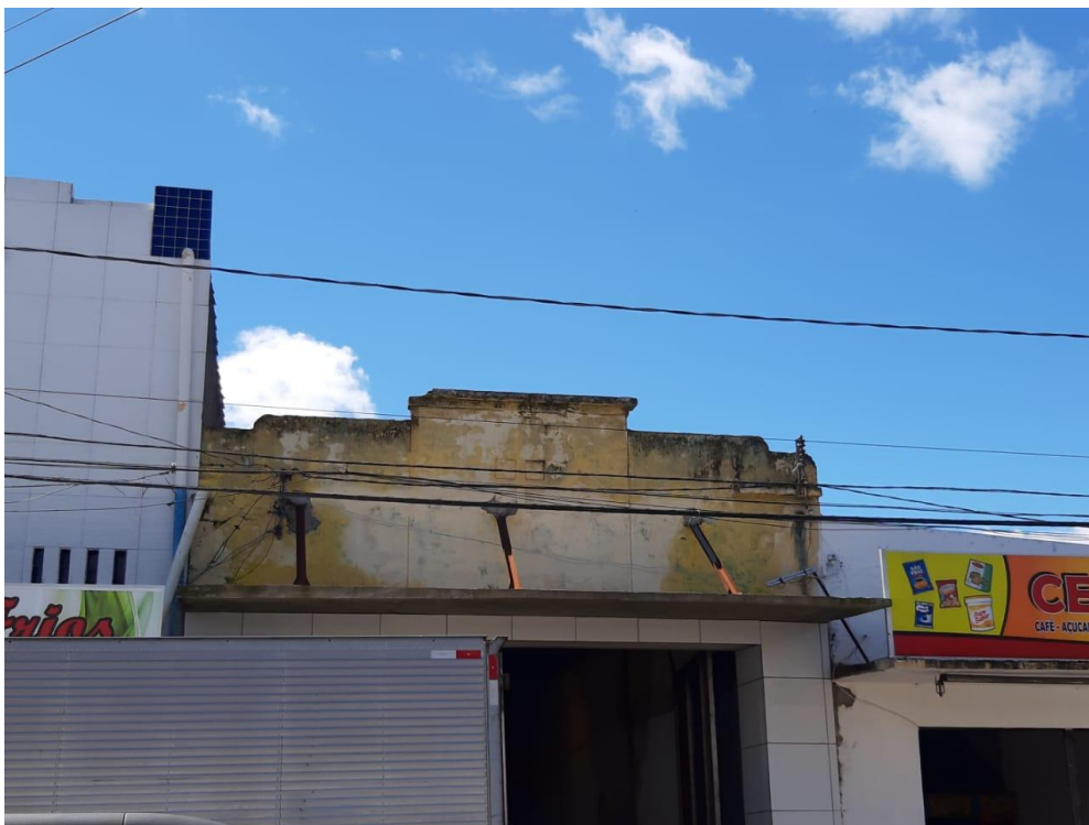
Fotografia 31 - Edificação localizada na Rua Pedro Álvares Cabral, Nº 86.
