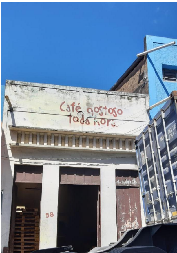
Fotografia 50 - Armazém localizado na Rua Dr. Carlos Agra, Nº 58.
