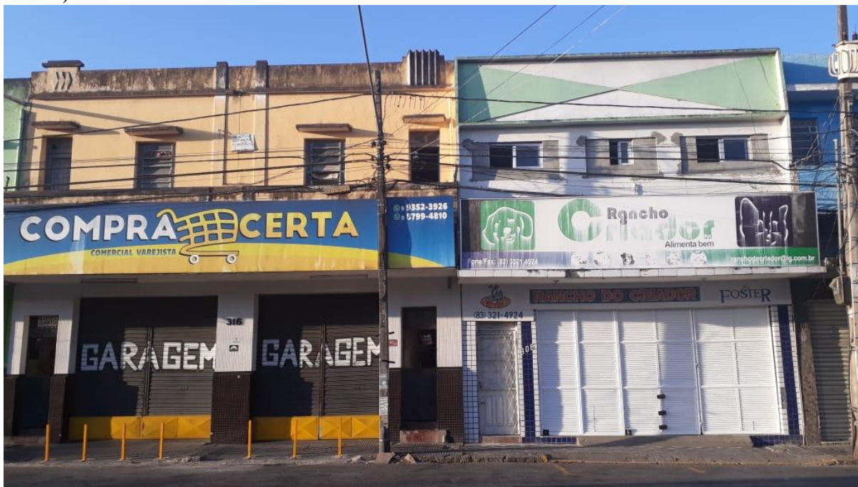
Fotografia 67. Edificações localizada na Rua Quebra Quilos, N° 316 (a esquerda) e 306 (a direita).
