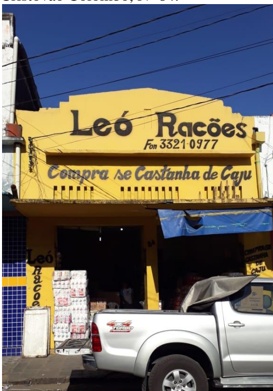
Fotografia 61 - Edificação localizada na Rua Cristovão Colombo, Nº 84.
