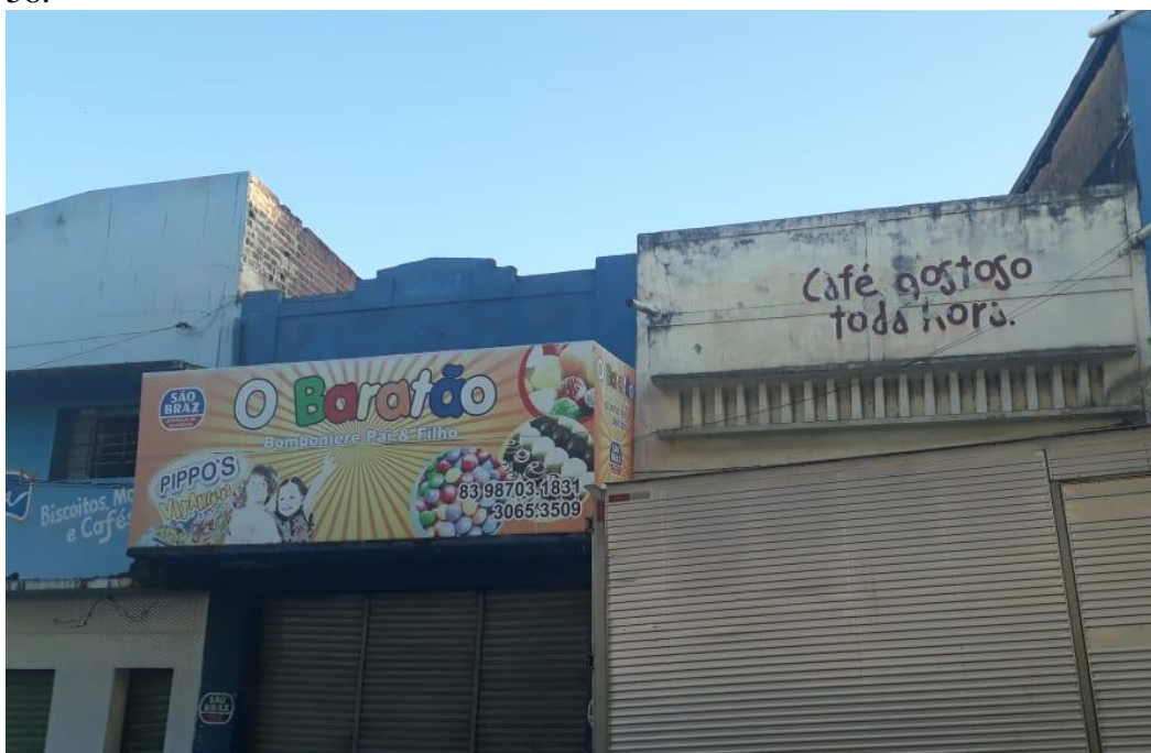
Fotografia 49 - Armazém localizado na Rua Dr. Carlos Agra, S/N, ao lado do armazém nº 58.
