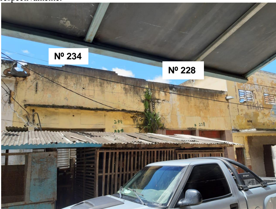
Fotografia 39 - Edificação localizada na Rua Pedro Álvares Cabral, N° 234 e N°228, respectivamente.
