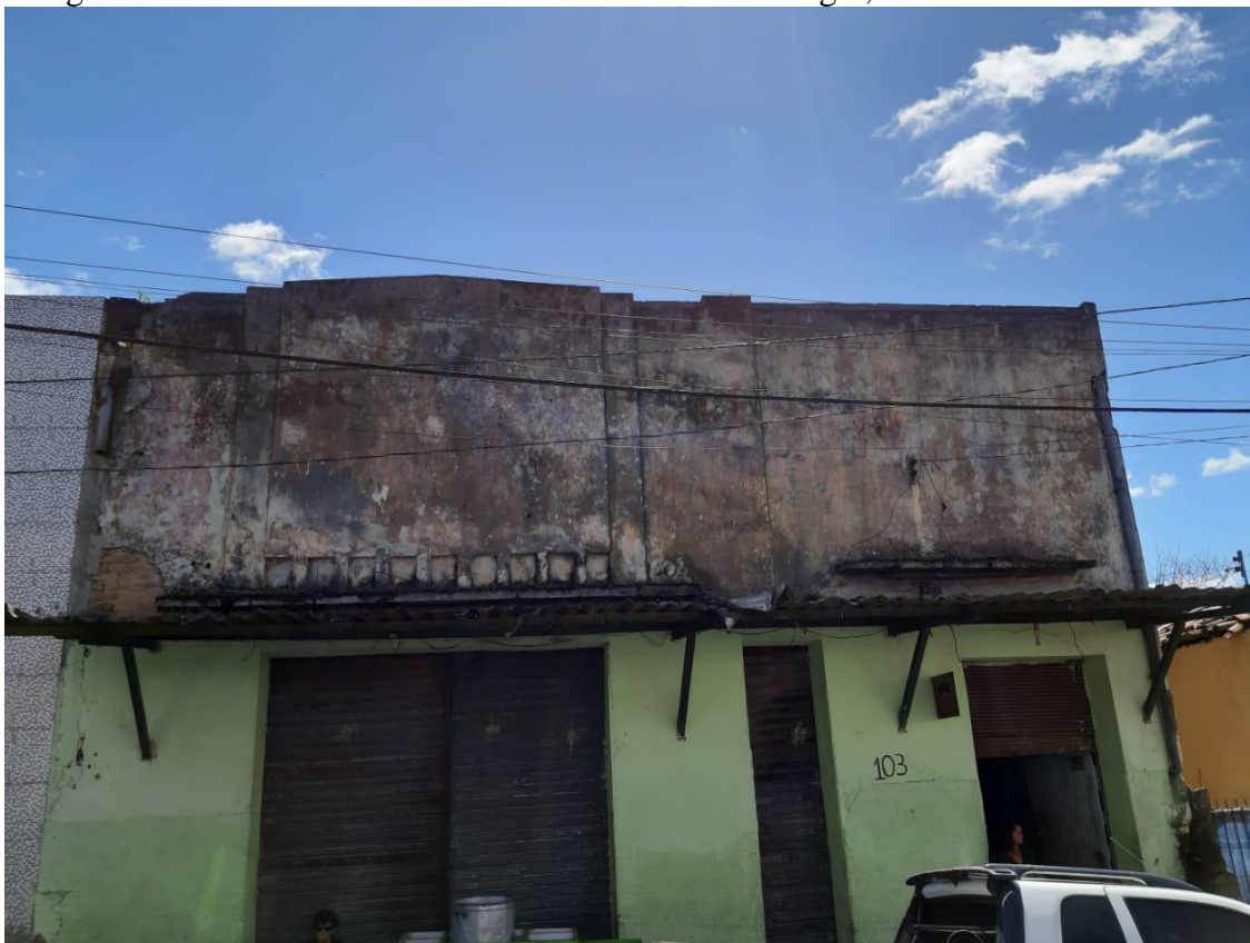
Fotografia 52 - Armazém localizado na Rua Dr. Carlos Agra, Nº 103.
