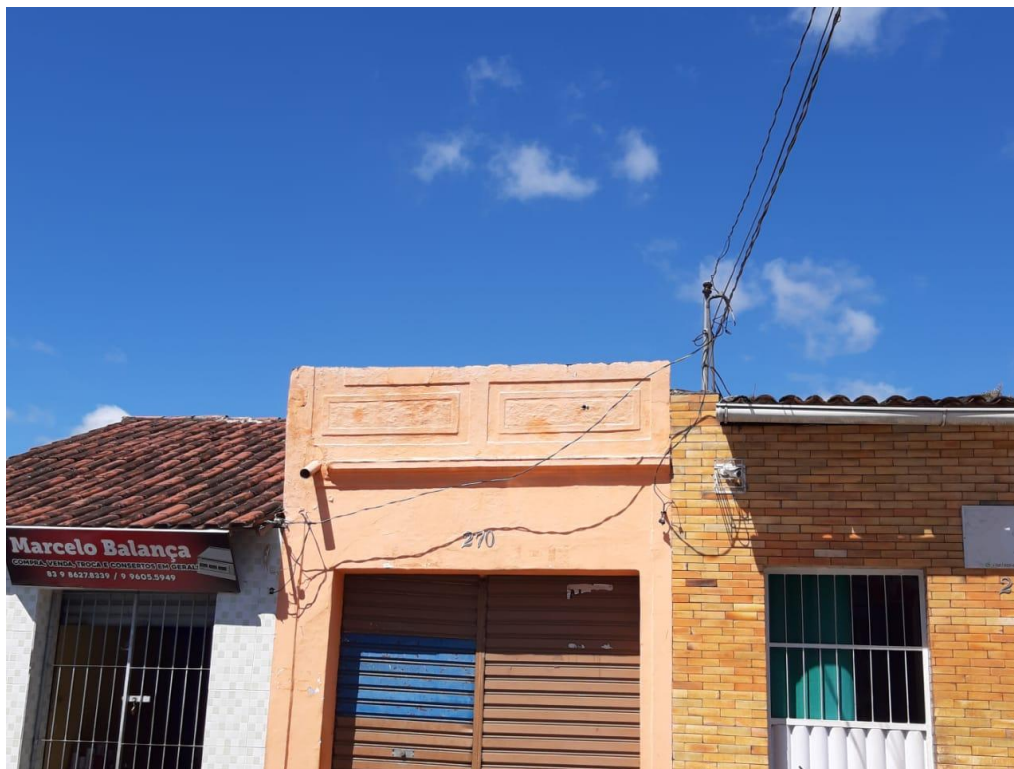
Fotografia 48 - Fachada de residência bem conservada, localizada na Rua Marcílio Dias, Nº 270.
