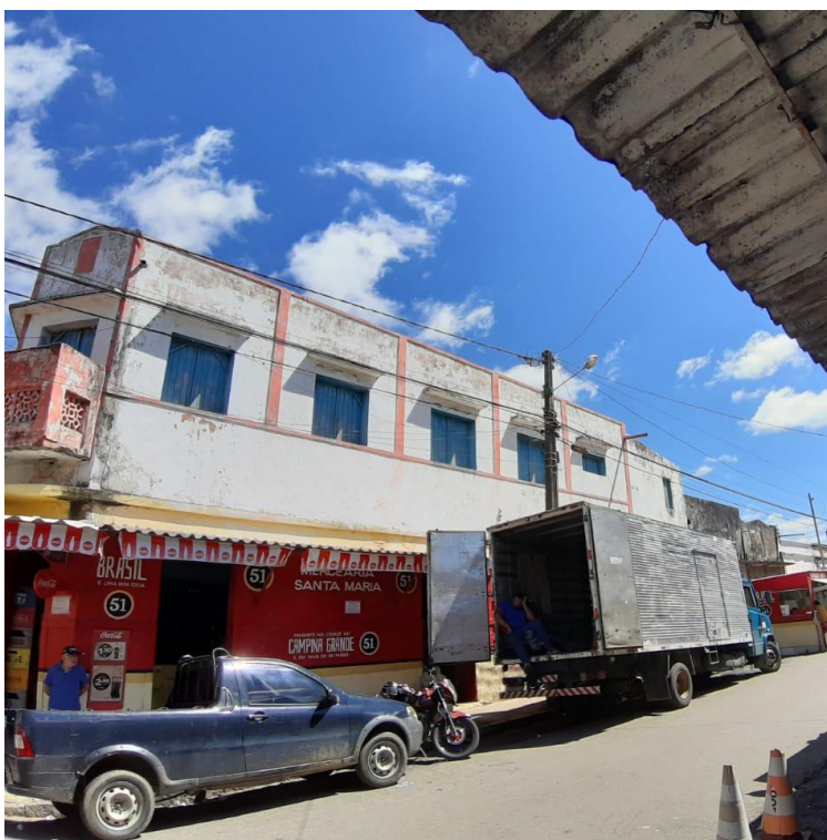
Fotografia 13 - Fachada lateral na rua Manoel Pereira de Araújo, S/Nº
