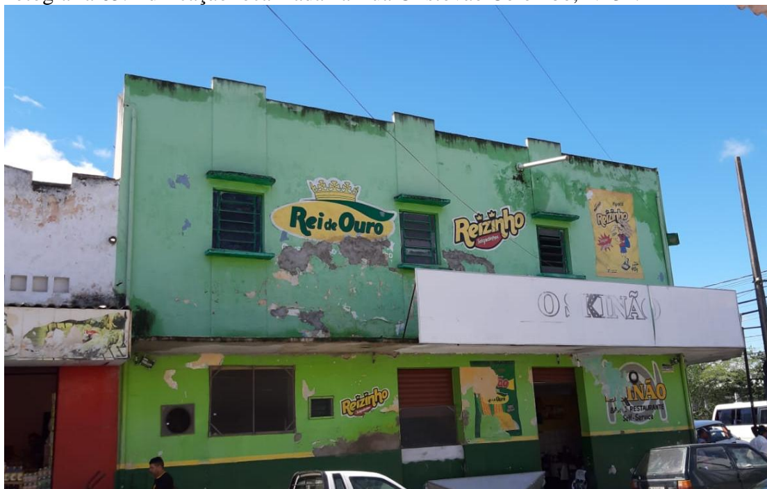
Fotografia 65. Edificação localizada na Rua Cristóvão Colombo, Nº 32.
