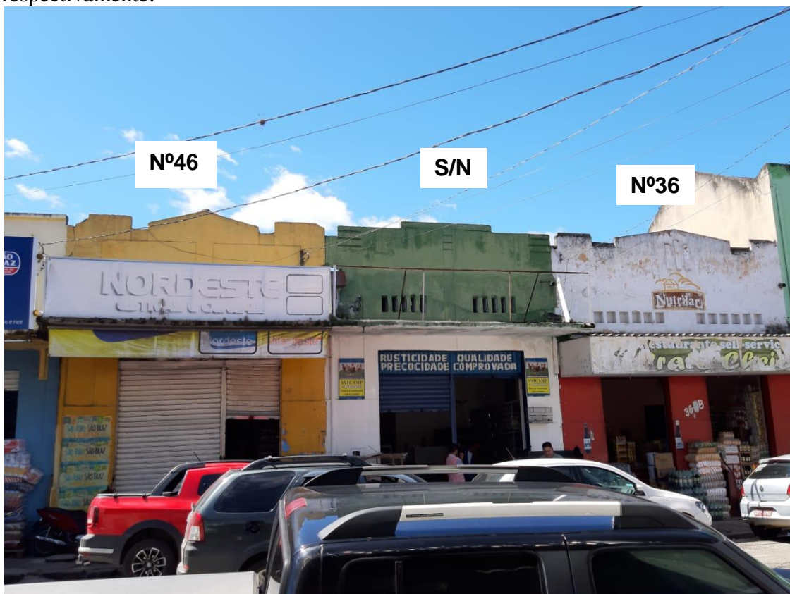
Fotografia 64 - Edificações localizadas na Rua Cristovão Colombo, Nº 46, S/N, Nº 36, respectivamente.
