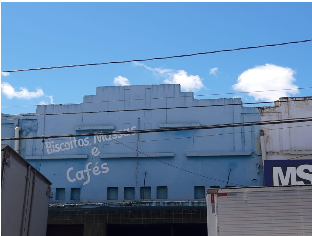
Fotografia 33 - Edificação localizada na Rua Pedro Álvares Cabral, Nº104.
