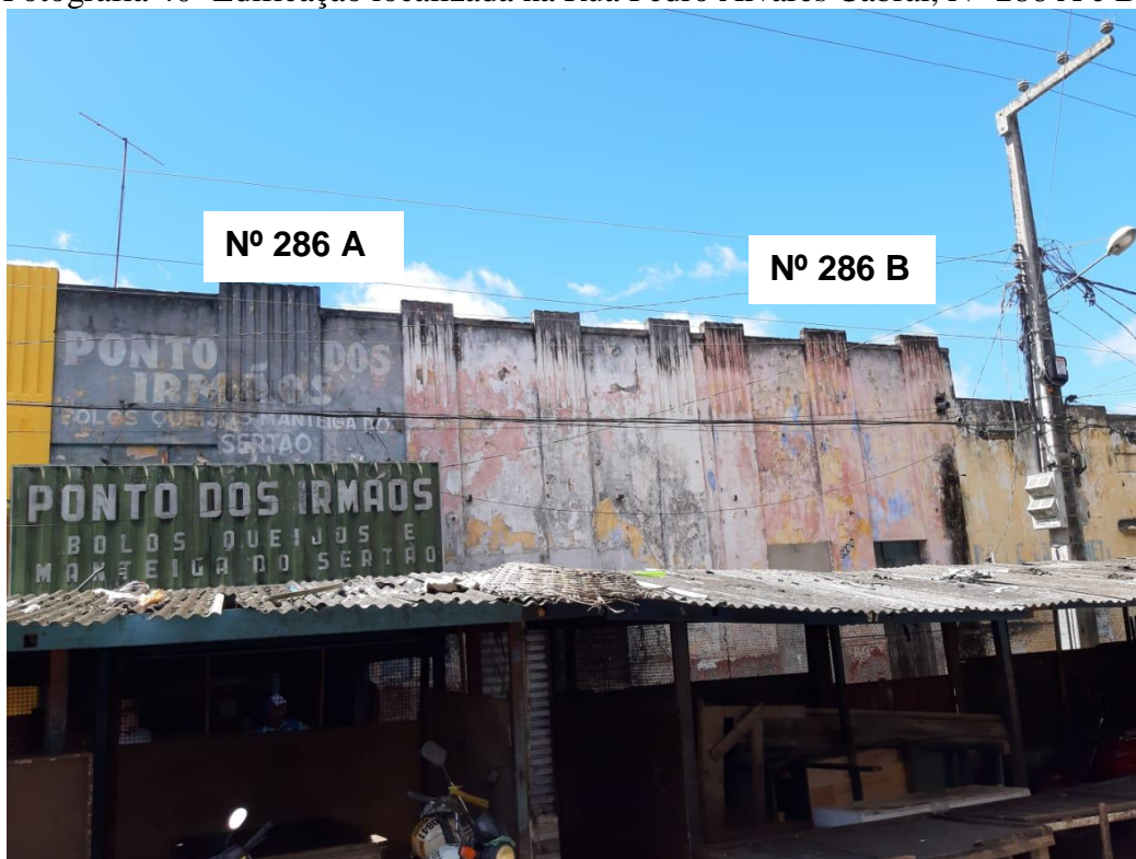
Fotografia 40- Edificação localizada na Rua Pedro Álvares Cabral, Nº 286 A e B.
