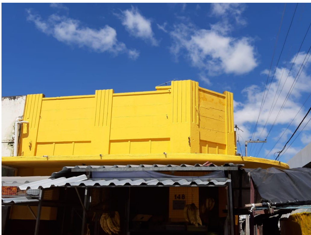
Fotografia 42 - Edificação localizada na Rua Marcilio Dias, Nº 148.
