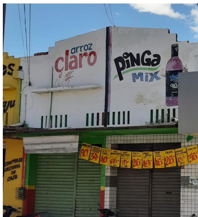
Fotografia 62 - Edificação localizada na Rua Cristovão Colombo, Nº 78
