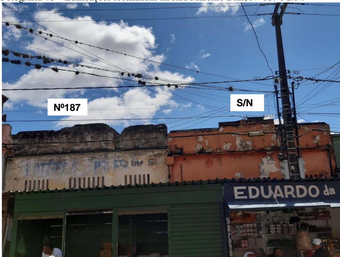
Fotografia 46 - Edificações localizadas na Rua Marcílio Dias, Nº 187 e S/N.
