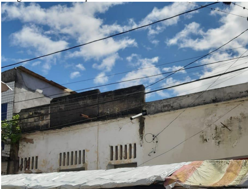
Fotografia 44 - Edificação localizada na Rua Marcílio Dias, Nº 158
