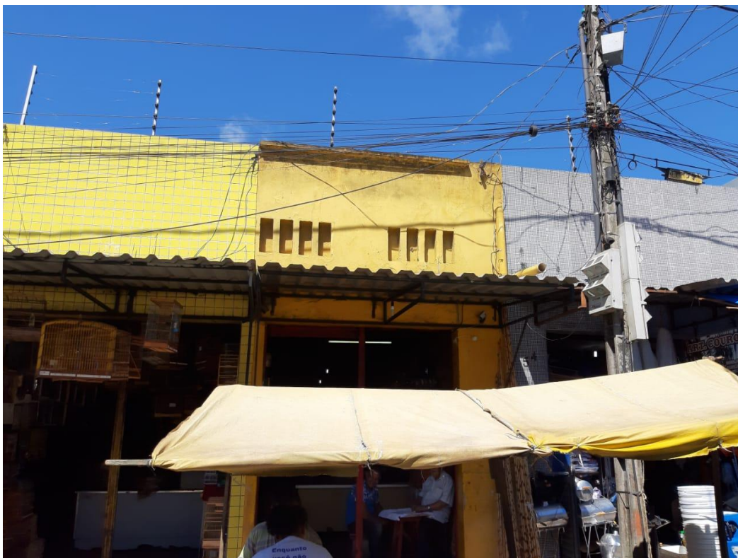
Fotografia 54 - Armazém localizado na Rua Manoel Farias Leite (feira de flores), Nº 58 B.
