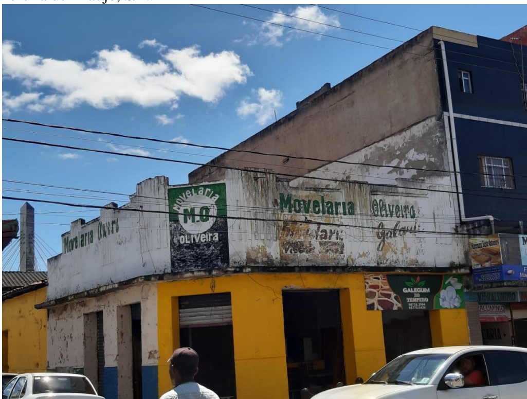
Fotografia 47 - Edificação localizada na Rua Marcílio Dias, esquina com a Rua Manoel Pereira de Araújo, S/N.
