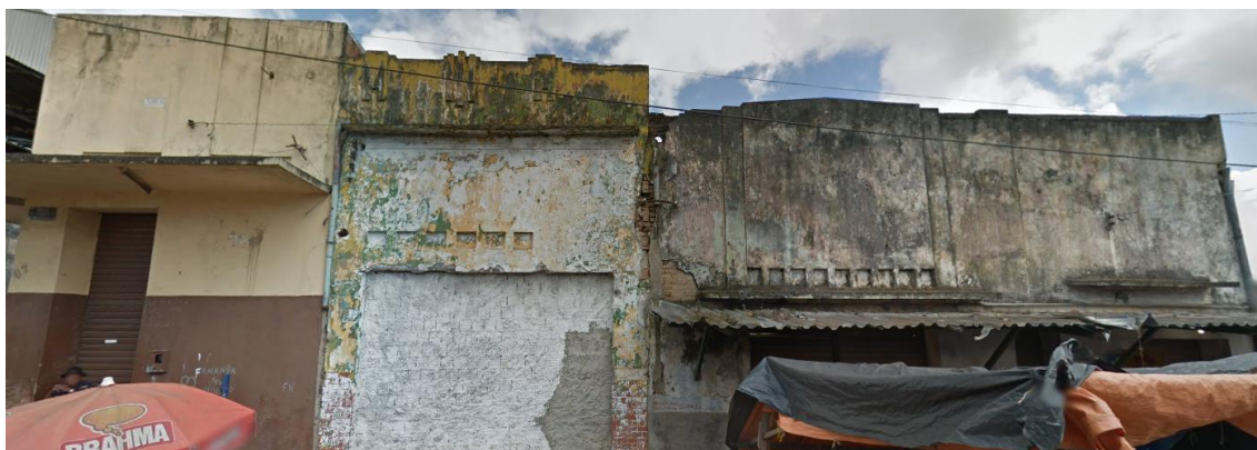
Figura 27 - Lateral da fachada da edificação com a proximidade de outra estrutura em Déco, localizado na Rua Dr. Carlos Agra, Nº 87.
