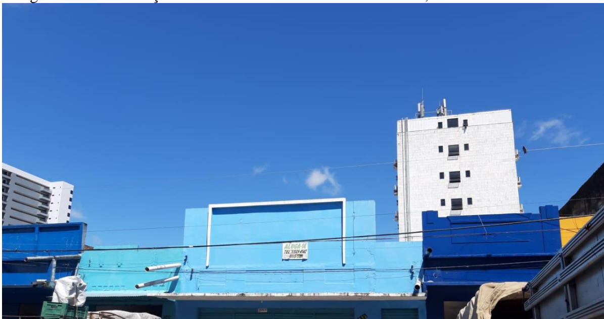
Fotografia 56 - Edificação localizada na Rua Cristovão Colombo, Nº 242.
