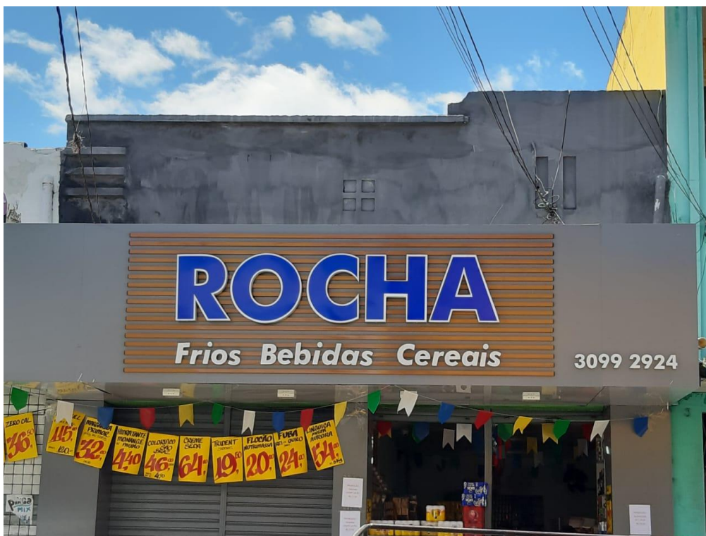
Fotografia 63 - Edificação localizada na Rua Cristovão Colombo, S/N.
