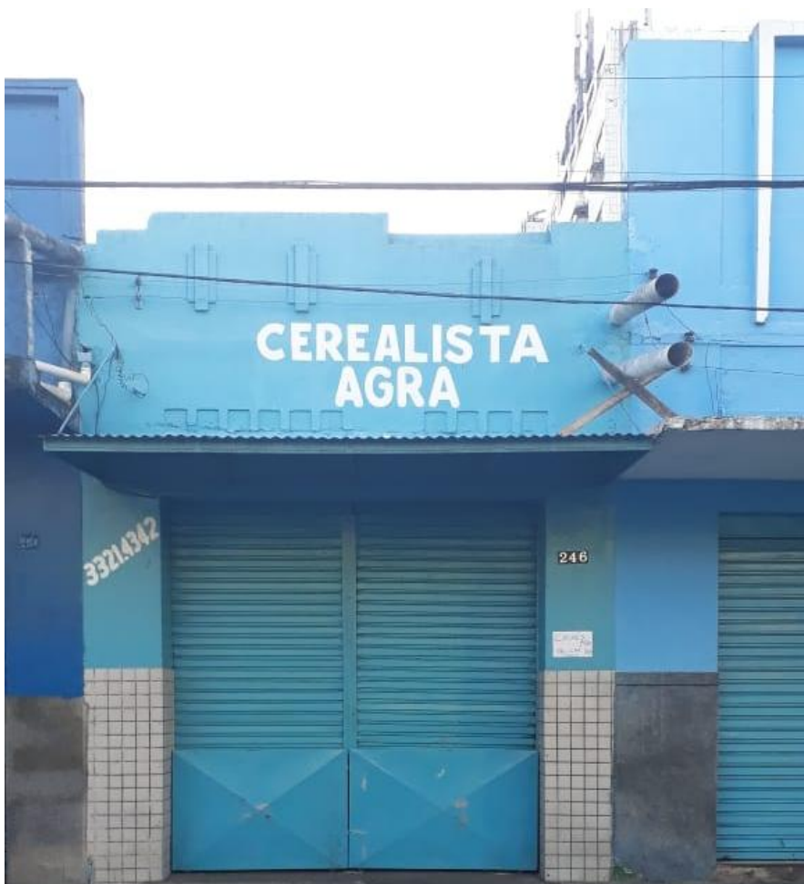
Fotografia 57 - Edificação localizada na Rua Cristovão Colombo, Nº 246
