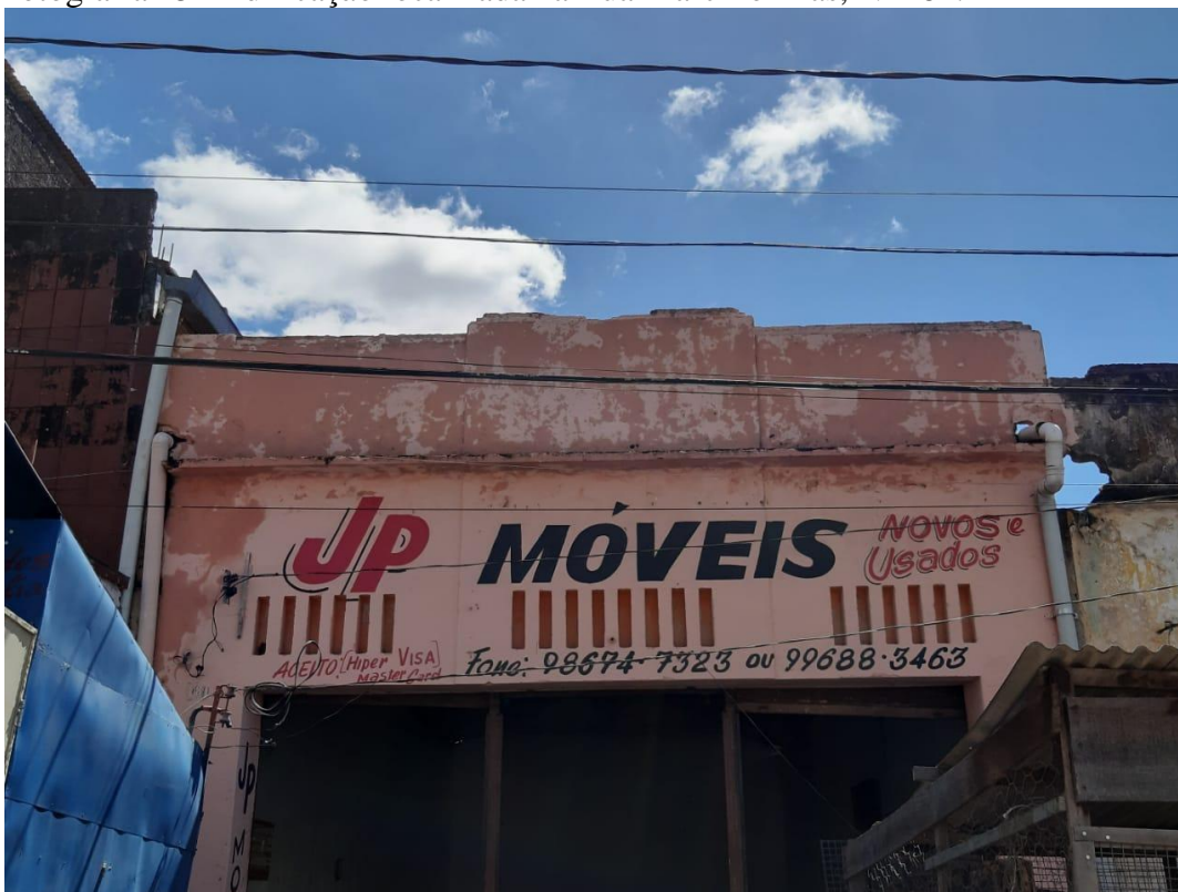
Fotografia 45 - Edificação localizada na Rua Marcílio Dias, Nº 181.
