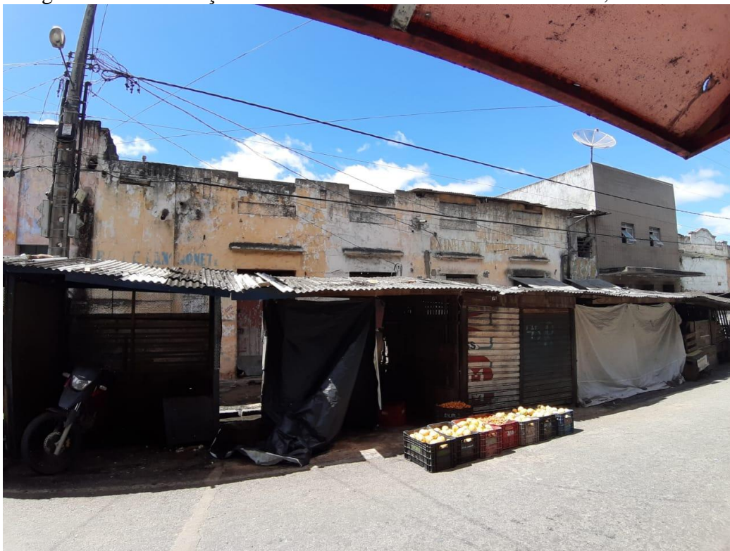
Fotografia 39 - Edificação localizada na Rua Pedro Álvares Cabral, Nº 274.
