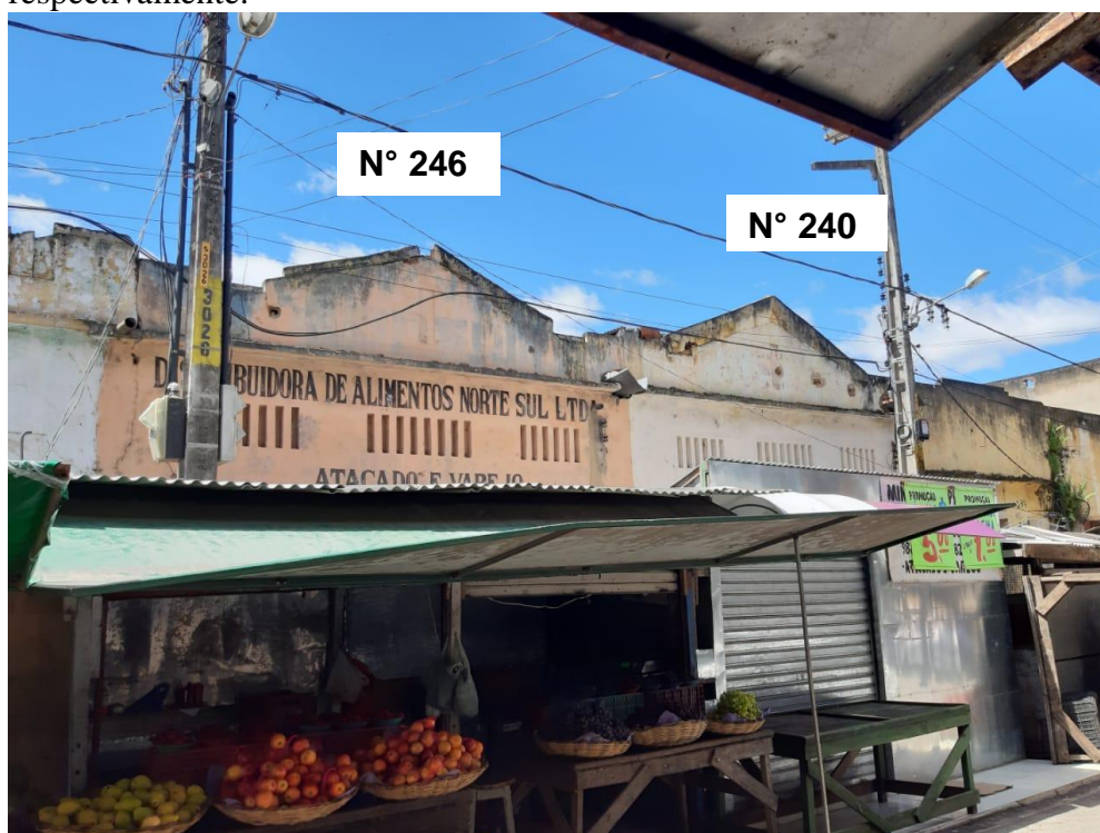
Fotografia 41 - Edificações localizadas na Rua Pedro Álvares Cabral, N° 246 e N° 240, respectivamente.
