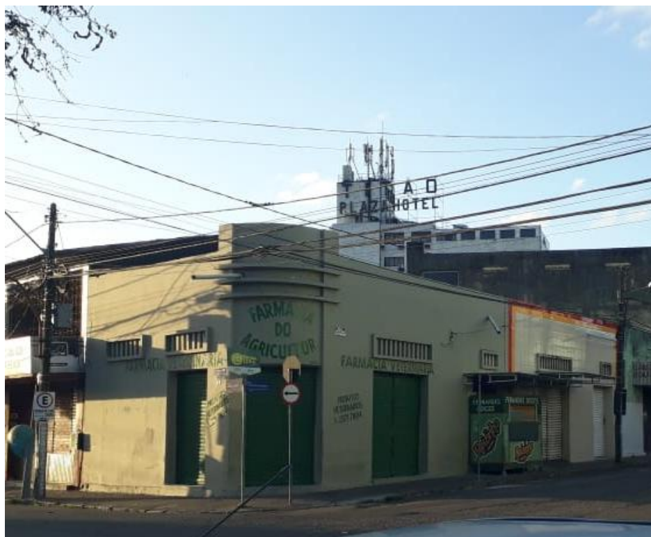
Fotografia 66- Edificação localizada nas Ruas Cristóvão Colombo e Quebra Quilos, Nº 242.
