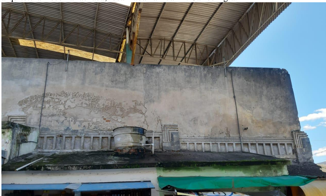
Fotografia 51 - Lateral do Mercado Novo, construído no ano de 1939, nota-se a presença da arquitetura Déco na fachada, localizada na Rua Dr. Carlos Agra.
