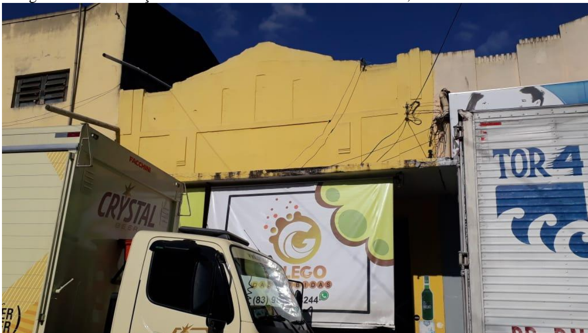
Fotografia 58 - Edificação localizada na Rua Cristovão Colombo, Nº 114.
