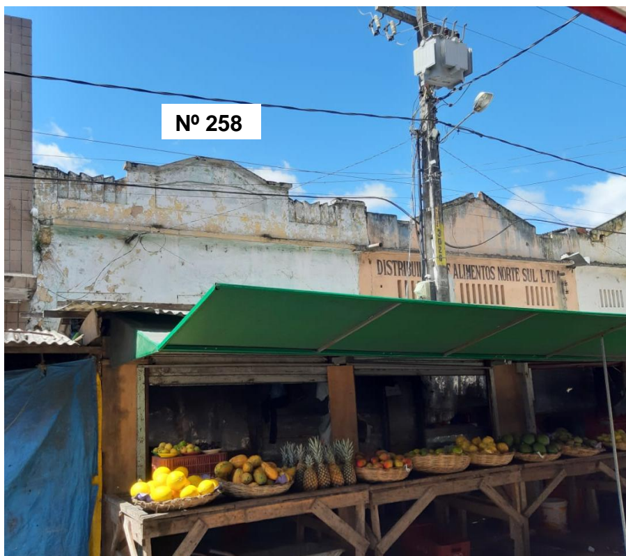
Fotografia 40 - Edificação localizada na Rua Pedro Álvares Cabral, N° 258.
