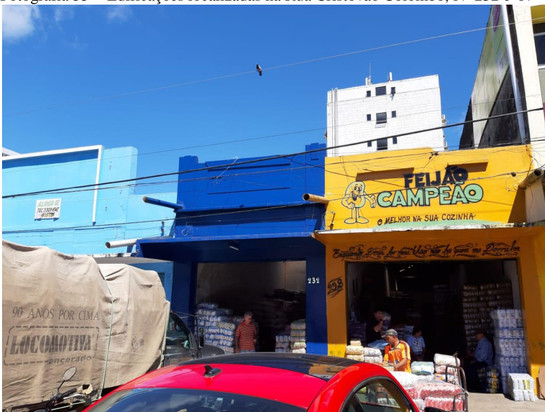
Fotografia 55 - Edificações localizadas na Rua Cristovão Colombo, Nº 232 e N º 228
