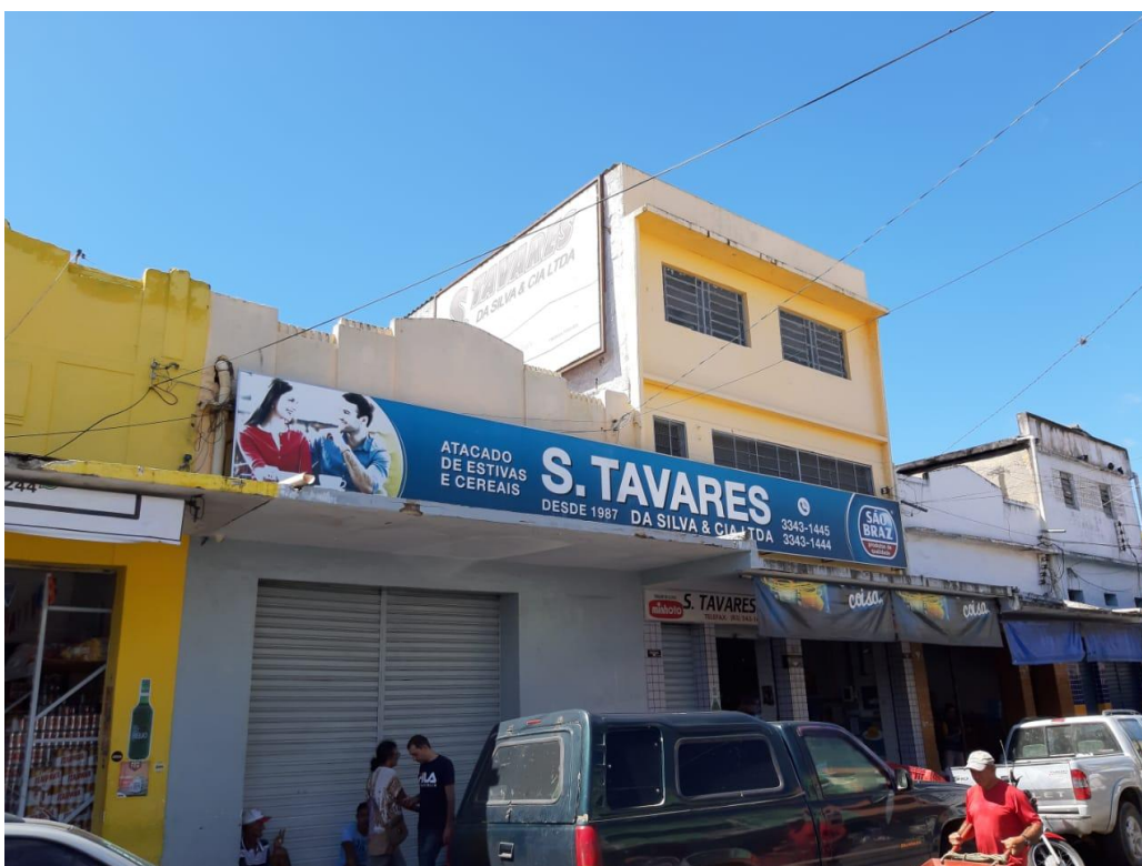
Fotografia 59 – Edificação localizada na rua Cristovão Colombo, S/N.
