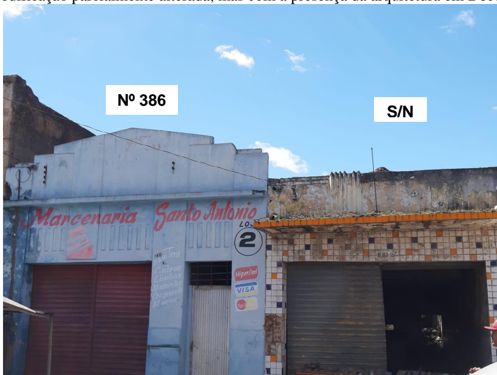
Fotografia 19 - Edificação localizada na Rua Manoel Pereira de Araújo Nº 386, ao lado edificação parcialmente alterada, mas com a presença da arquitetura em Déco no topo, S/N
