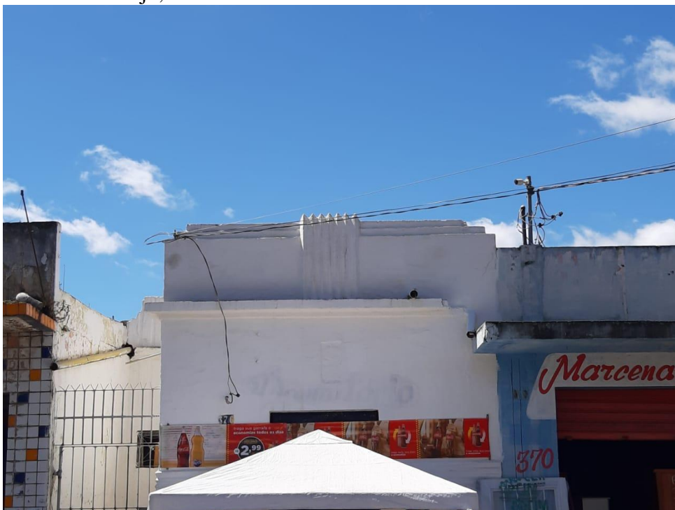
Fotografia 18 - Fachada bem conservada da arquitetura em Déco, localizada na Rua Manoel Pereira de Araújo, nº 376.
