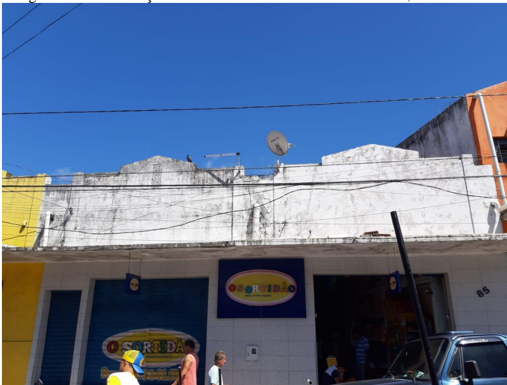
Fotografia 60 - Edificação localizada na Rua Cristovão Colombo, Nº 85.
