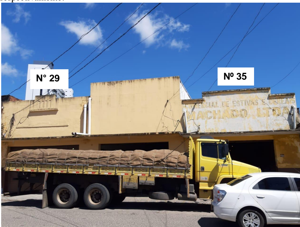
Fotografia 34 - Edificações localizadas na Rua Pedro Álvares Cabral, Nº 29 e Nº 35, respectivamente.
