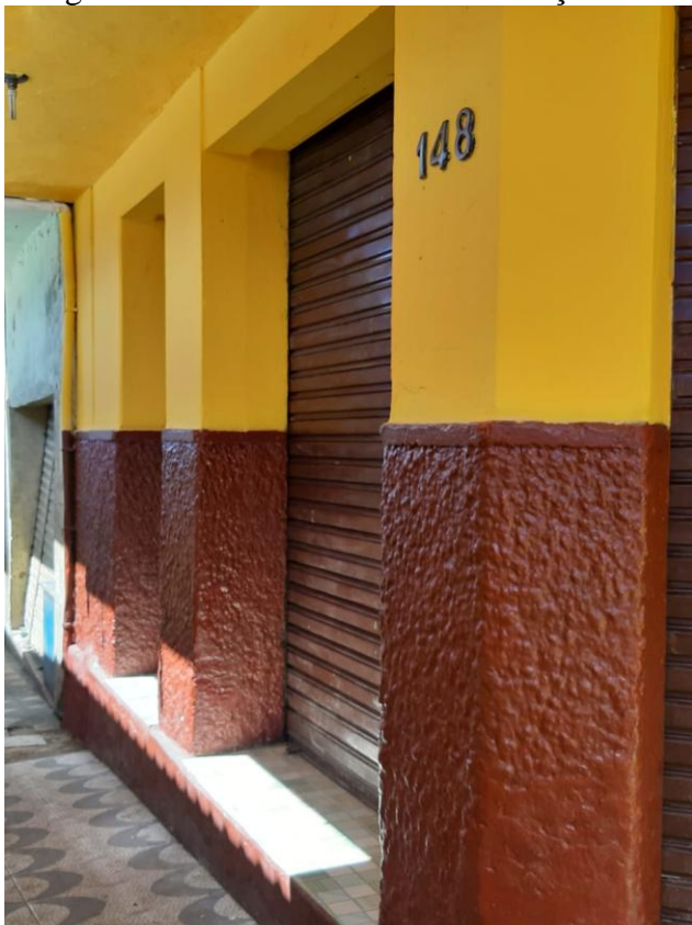
Fotografia 43 - Parte inferior da edificação localizada na Rua Marcílio Dias, Nº 148.
