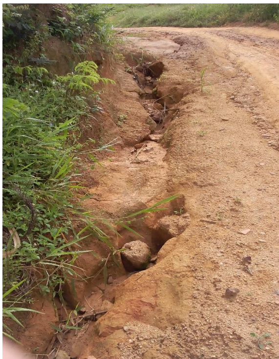
Figura 15: processo de erosão, devido a retirada da cobertura vegetal e atividade antrópica
